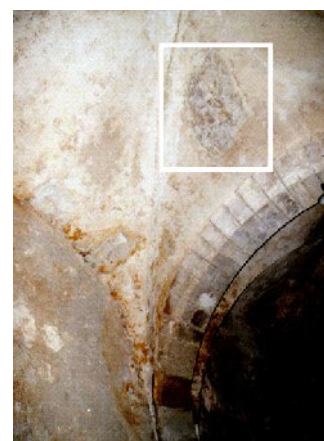
49. Détail de la voûte inférieure
