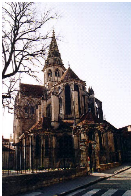
71. Vue de l'église depuis le sud-est
