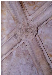
54. Détail d'une clef de voûte
