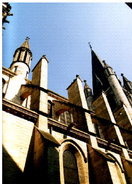
81. Contrebutement côté sud
