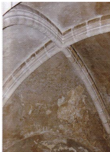
45. Détail de la voûte du niveau supérieur
