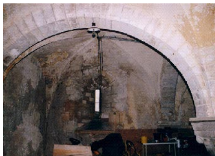
48. Vue sur la voûte du niveau inférieur
