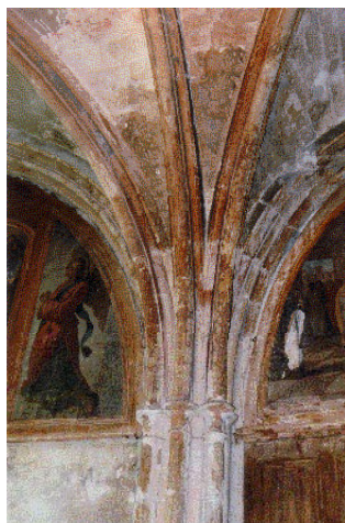
52. Détail de la voûte
