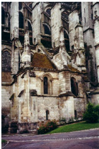
44. Sacristie du XII e siècle: Vue depuis le nord
