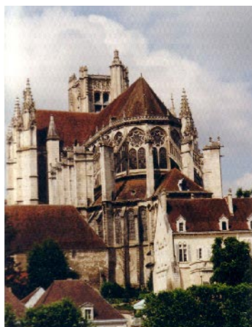
159. Vue côté sud-est
