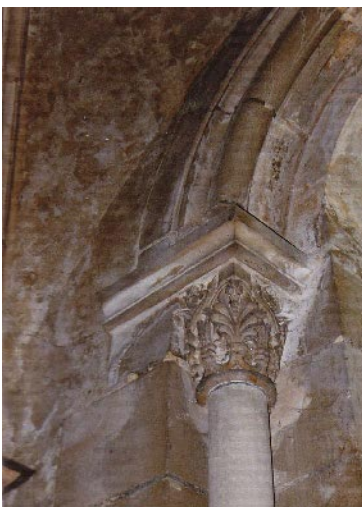
202. Chapiteau intérieur à gauche de la baie de fenêtre au niveau supérieur, côté est
