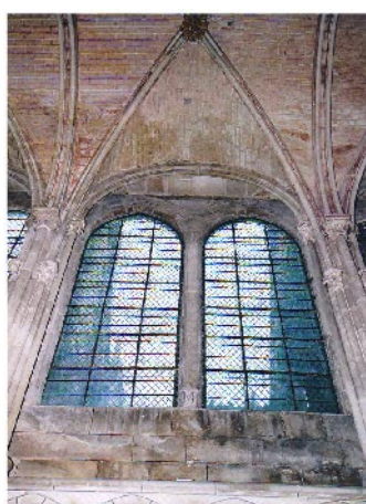
156. Parement intérieur baie 27/29
