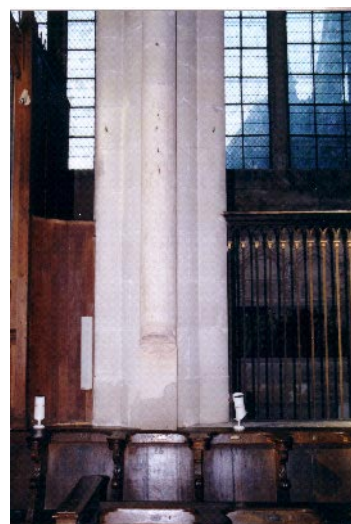
151. Détail pilier C
