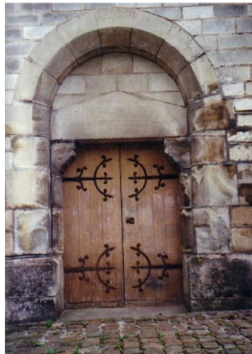
200. Porte d'entrée du sous-sol, côté est
