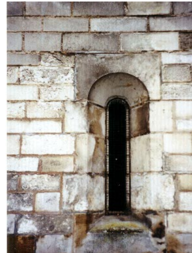
201. Fenêtre du sous-sol, côté nord
