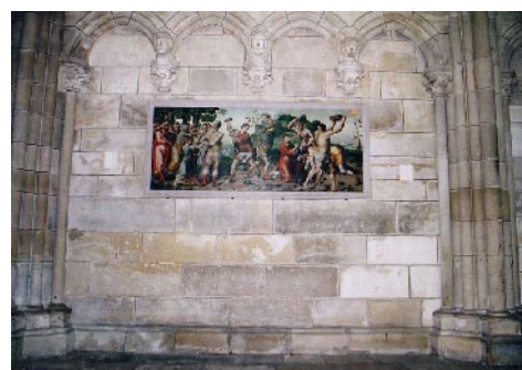
157. Parement intérieur de l'arcature 27/29
