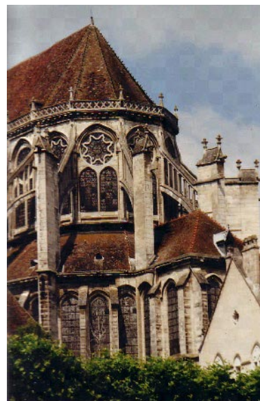
158. Couvertures côté sud-est
