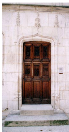
169. Porte de Jean Baillet donnant accès aux appartements préfectoraux
