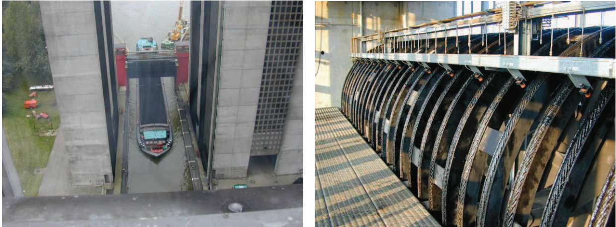
Abb. 22: (links) Schiffshebewerk; (rechts) Doppelseilscheiben im SHW
