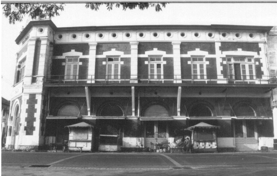
Abb. 61: Nordseite des „Marba“-Büros (Gebäude A2)
