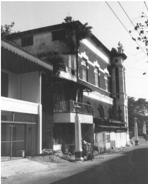
Abb. 60: Südseite des „Marba“-Büros (Gebäude A2)
