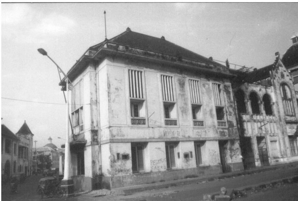
Abb. 67: Westseite des Rechtsanwaltsbüros (Gebäude B3)
