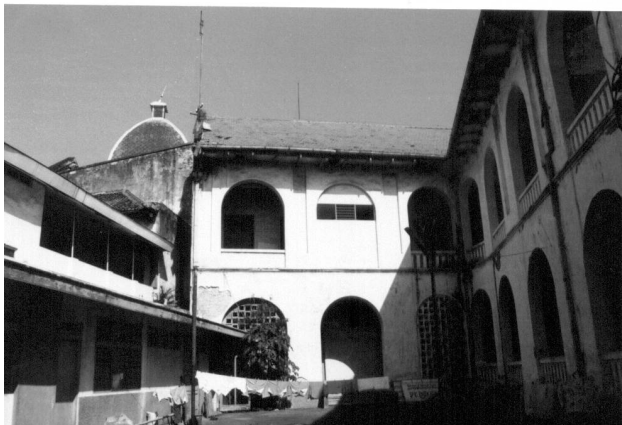
Abb. 97: Ostseite des „P.T.P. XV“-Plantagenbetriebs (Gebäude C6)
