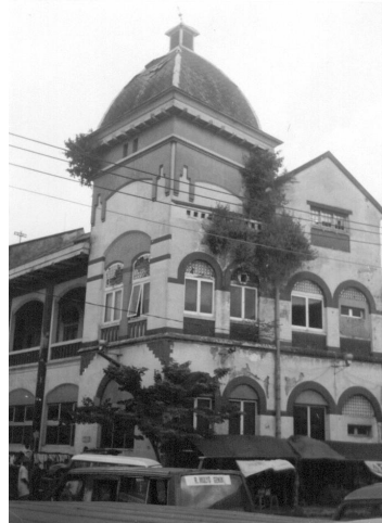
Abb. 96: Südseite des „P.T.P. XV“-Plantagenbetriebs (Gebäude C6)
