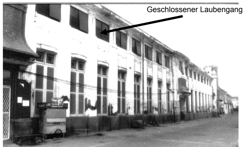
Abb. 77: Südseite des „P.T. Pelni“-Büros (Gebäude B4)
