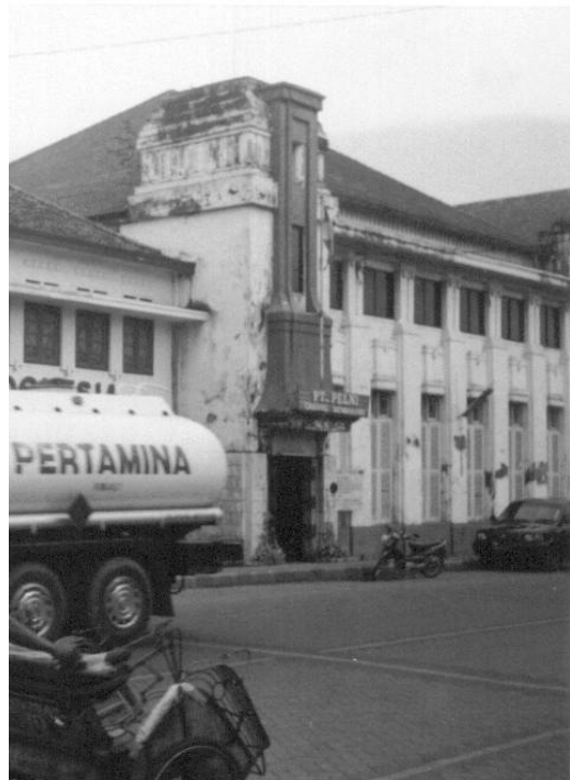
Abb. 79: Nord-Teil des „P.T. Pelni“- Büros (Gebäude B4)
