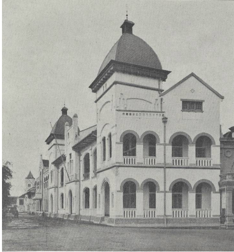
Abb. 94: N.V. Cultuur Maatschappij de Vorstenladen gebaut 1887, Foto im Jahr 1930 (Gebäude C6) [54]
