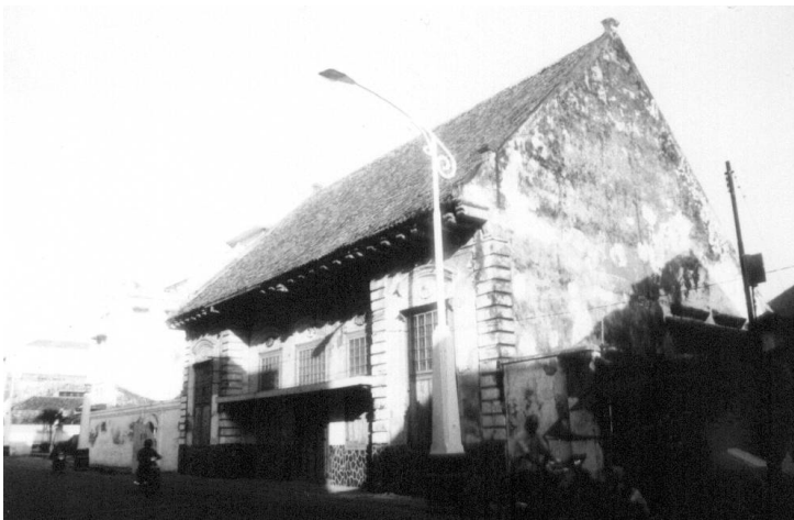
Abb. 51: Ostseite des Wohnhauses (Gebäude A1)
