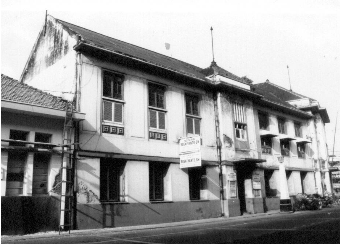
Abb. 68: Nordseite des Rechtsanwaltsbüros (Gebäude B3)
