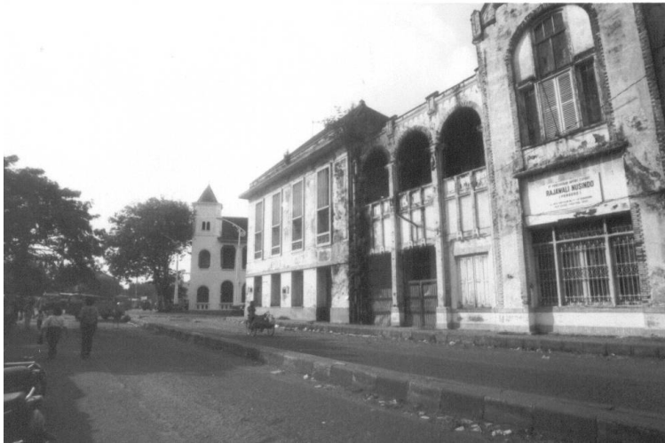
Abb. 70: Südseite des Rechtsanwaltsbüros (Gebäude B3)
