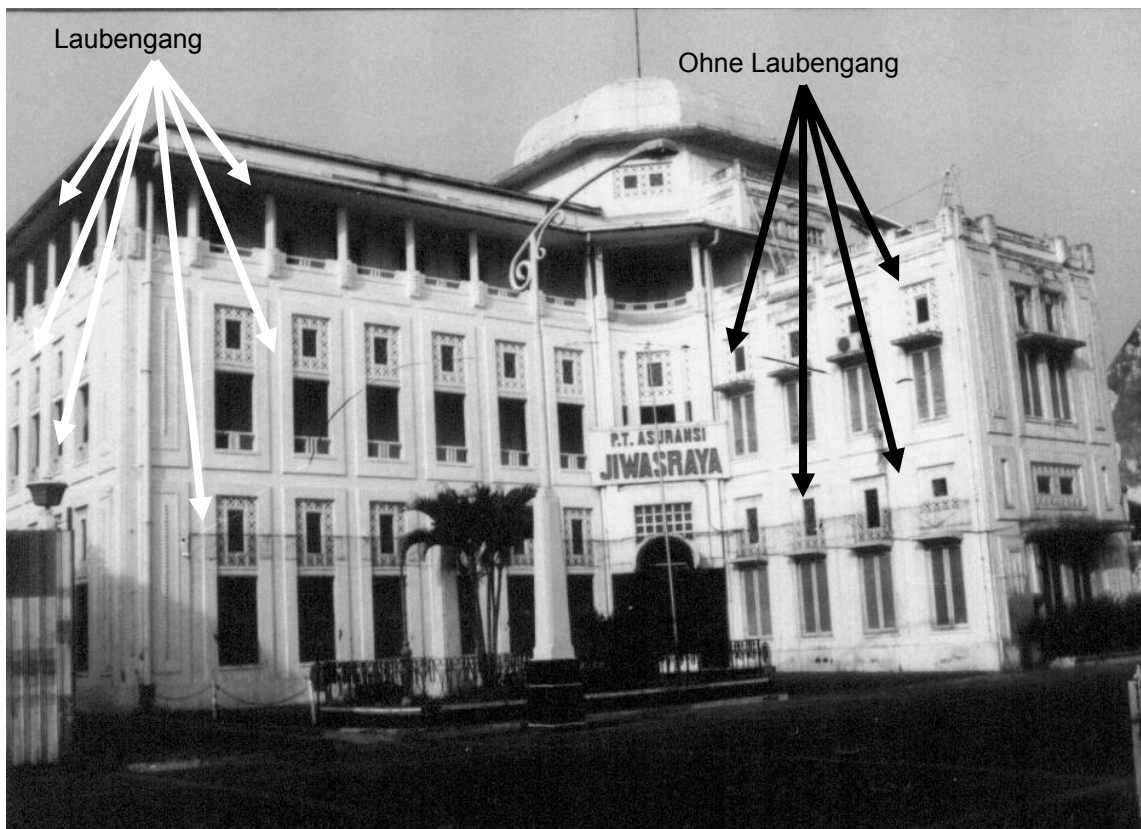
Abb. 86: Nordseite des „Jiwasraya“-Versicherungsbüros (Gebäude C5)
