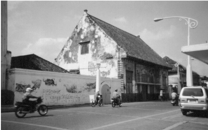
Abb. 50: Westseite des Wohnhauses (Gebäude A1)
