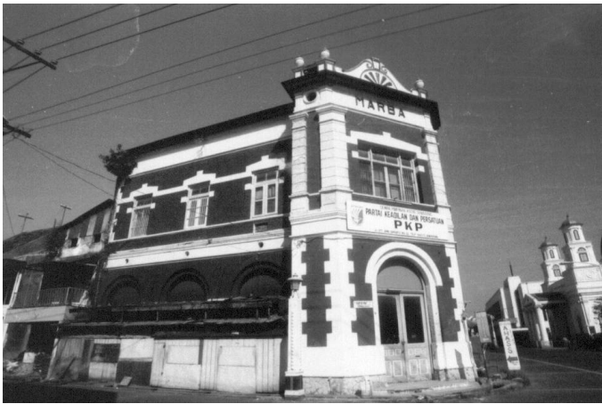
Abb. 59: Ostseite des „Marba“-Büros (Gebäude A2)
