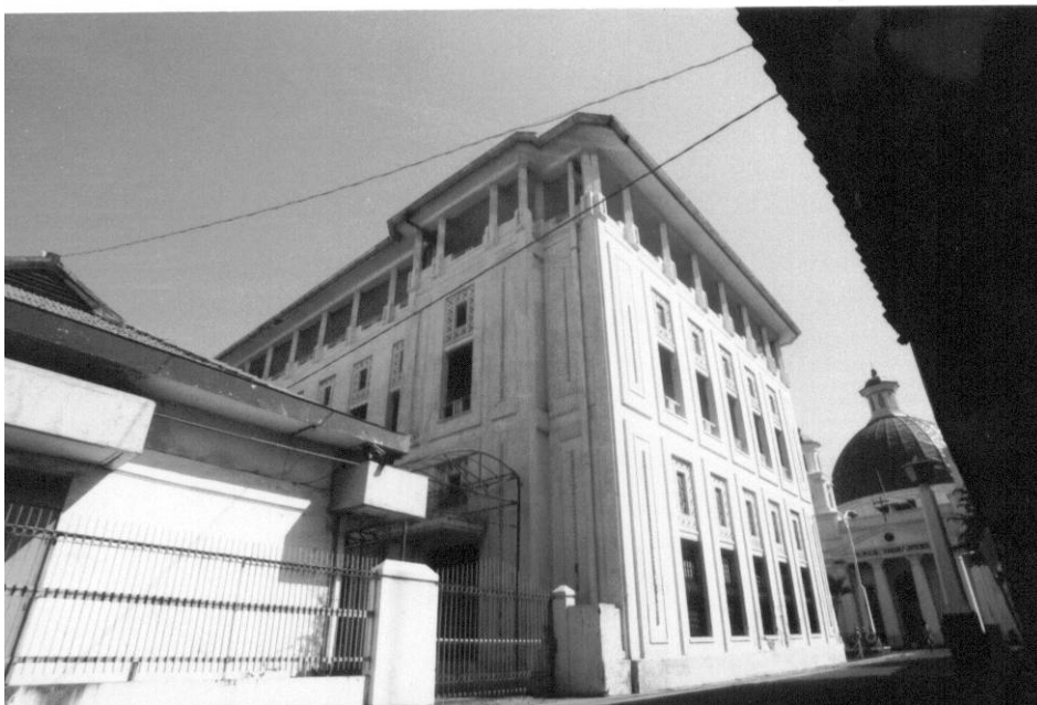
Abb. 88: Südostseite des „Jiwasraya“-Versicherungsbüros (Gebäude C5)
