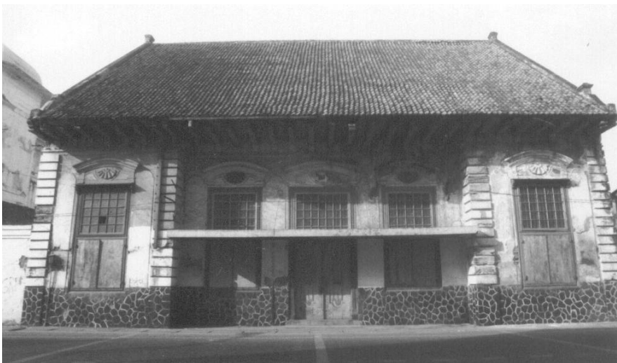
Abb. 52: Nordseite des Wohnhauses (Gebäude A1)
