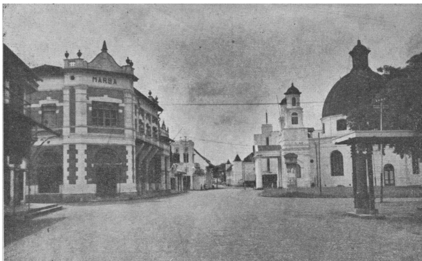
Abb. 57: „Marba“-Büro gebaut 1850, Foto im Jahr 1933 (Gebäude A2) [78]
