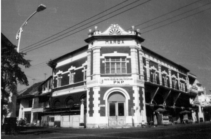
Abb. 58: Nordostseite des „Marba“-Büros (Gebäude A2)
