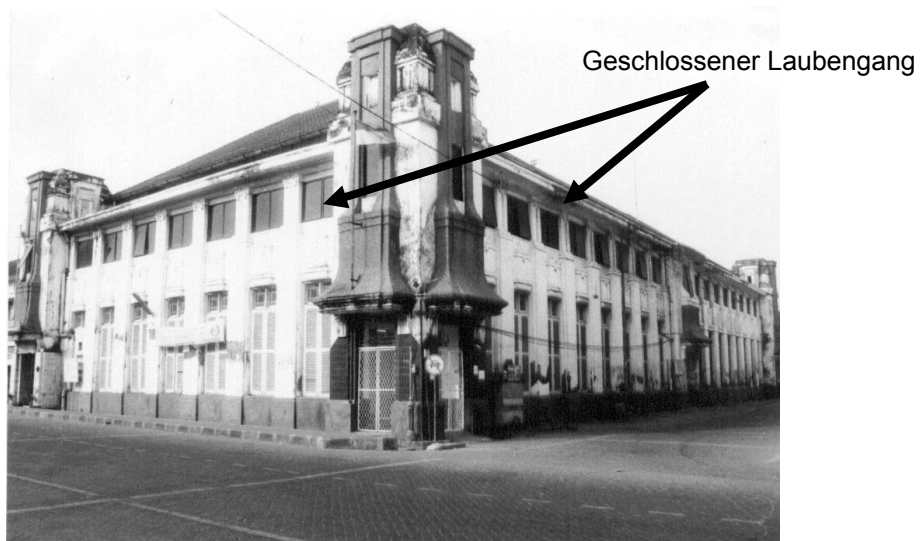
Abb. 76: Südwestseite des „P.T. Pelni“-Büros (Gebäude B4)
