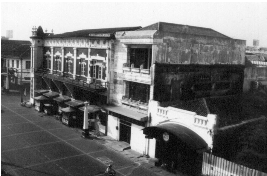
Abb. 62: Westseite des „Marba“-Büros (Gebäude A2)
