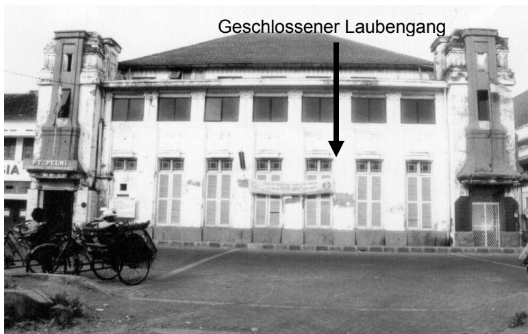
Abb. 75: Westseite des „P.T. Pelni“-Büros (Gebäude B4)
