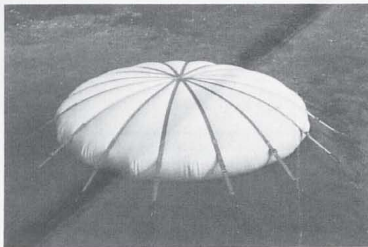
Bild 5. Pneumatische Schalung für eine Stahlbetonschale
