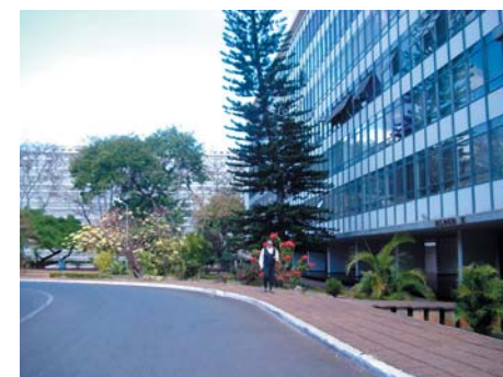
Abb. II.43: Ursprüngliche „en vogue“ Fassade (abgehängte Glasfassade) eines Wohnblocks (SQS 315).
