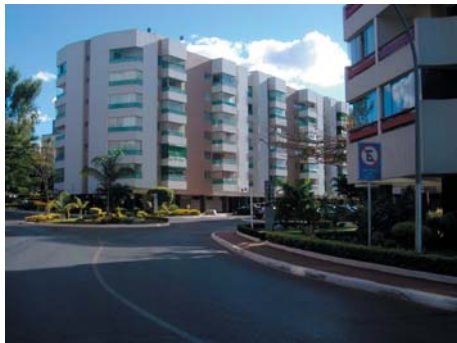
Abb. II.46: Fassade ist durch Balkone nicht mehr bündig (SQN 309).
