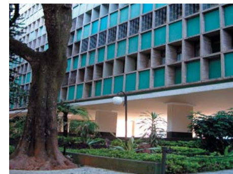
Abb. II.44: Ursprüngliche Farbgebung der Fassade (SQS 303).
