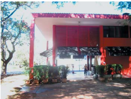
Abb. II.4: Die Rückseite des Restaurants „Marvin“. Quelle: Verfasser, 2003.
