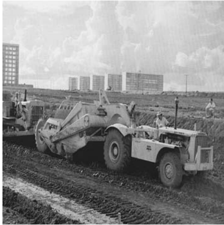
Abb. I.2: Bau der Ministerengebäude, 1958. Quelle: Puttkamer, 2000. S.32
