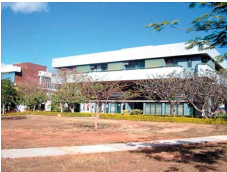
Abb. II.41: Rückseite des Geschäftsblocks der lokalen Einkaufstraße CLN 308/309. Quelle: Verfasser, 2003.
