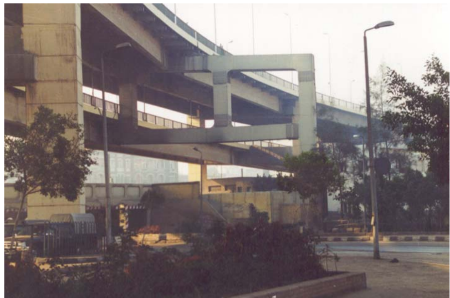
Abb. 5.15: Der Zusammenhang zwischen Lehrbüchern, Übungsaufgaben und Bauresultat am Beispiel eines Ausschnitts der „Brücke des 6. Oktober“ in Kairo, Ägypten.
