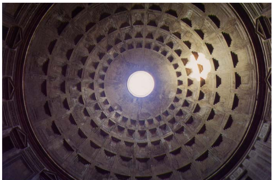
Abb. 2.41: Die kassettierte Decke des Pantheons
