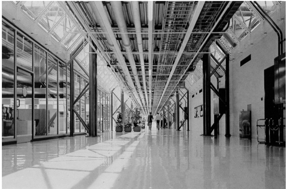
Abb. 4.11: Blick in die Kommunikationsstrasse der Inmos-Halle
