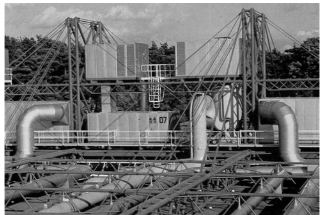
Abb. 4.21: Dachaufsicht, außenliegende Verteilungskanäle zu den unterschiedlichen Nutzungsbereichen
