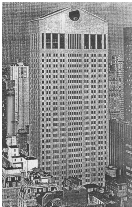
Abb. 2.1: Das AT&T Building in New York von Philip Johnson und John Burgee.
