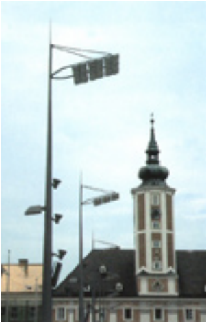
Abb. 4.5.2-04. Die Beleuchtungsmasten mit vier Scheinwerfern und Reflektorbildschirm; Gehl; Gemzøe, 2000 S.138
