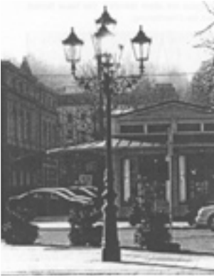
Abb.4.2.1-04. Die historische Beleuchtungsanlage; Markelin, 2000 S.6
