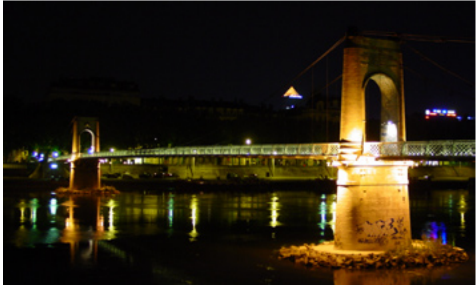
Abb. 4.2.6-10. Die Beleuchtung der La Fayette Brücke
