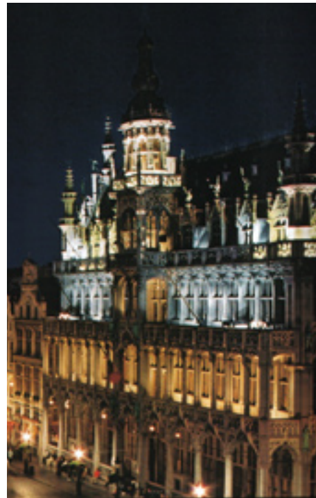
links Abb. 4.7.1-06. Die Fassadenanstrahlung des Rathauses am Grand Place in Brüssel; ilr 012 S.20
