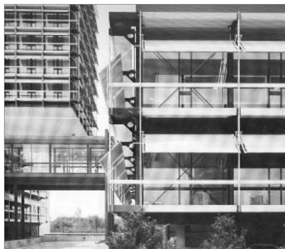
91 Olivetti in Frankfurt 1968-1972, Egon Eiermann: Zweischalige Fassadenkonstruktion mit Sonnensegeln
