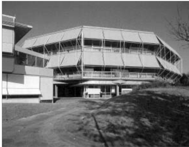
89-90 Fassade mit steuerbaren Markisen, Fassadenausschnitt mit Stangensystem zur Führung des Sonnenschutzes
