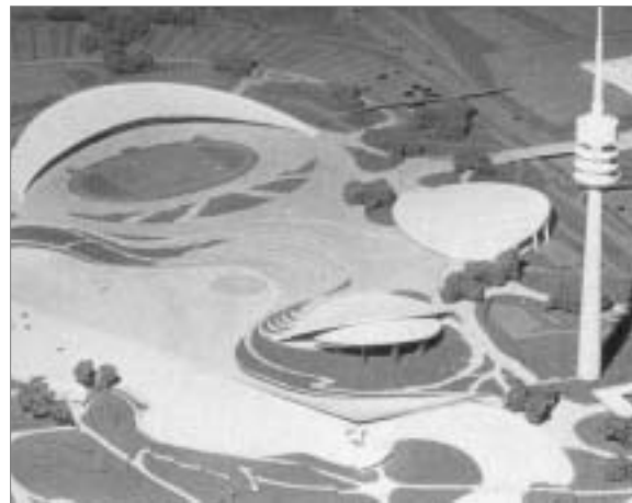
19-20 Beauftragte Konstruktionsvarianten: punktgestützte (a) und randgestützte (e) Hängedächer
