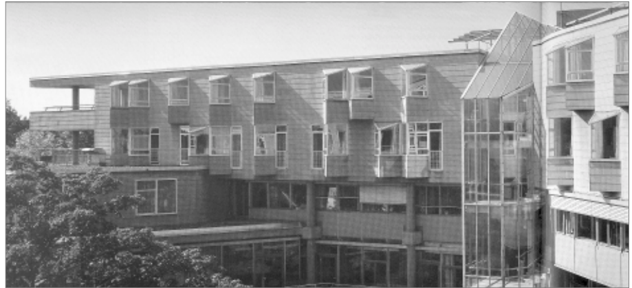
122 Fassade zum Gartenbereich mit den Erkern der Wohnbereiche
