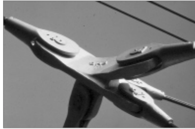
61-63 Fundamente und Verankerungen (ganz oben): Schwergewichtsfundament als Widerlager für das Stadionrandkabel; Litzenbündel des Hauptrandkabels, noch nicht im Spannblock verankert; Fundament mit vorgespannten Injektionsankern 64-66 Gussteile: Sattel zur Umlenkung von Randseilen; Knotenpunkt am hinteren Rand des Stadionsdaches; Abspannpunkt vor der Schwimmhalle
