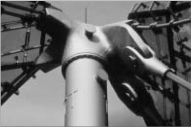
61-63 Fundamente und Verankerungen (ganz oben): Schwergewichtsfundament als Widerlager für das Stadionrandkabel; Litzenbündel des Hauptrandkabels, noch nicht im Spannblock verankert; Fundament mit vorgespannten Injektionsankern 64-66 Gussteile: Sattel zur Umlenkung von Randseilen; Knotenpunkt am hinteren Rand des Stadionsdaches; Abspannpunkt vor der Schwimmhalle
