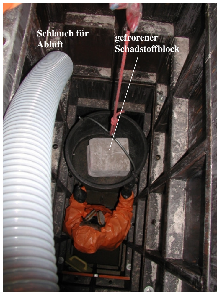
Abb. 7.4: Einbau der gefrorenen Schadstoffblöcke
