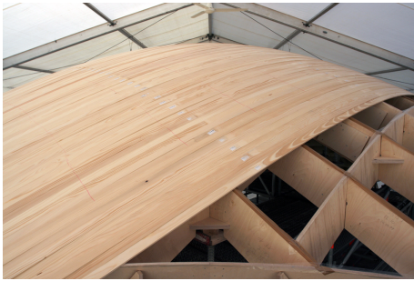
(a) Unterkonstruktion und erste Lage
