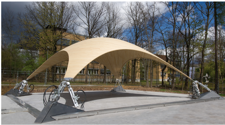
Abbildung 7.3 Prototyp Stuttgart SmartShell (Foto: Bosch Rexroth AG). Im Vordergrund links dargestellt ist das aktive Auflager 1 (siehe Abschnitt 7.1.2).
