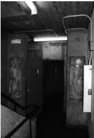
△ Abb. 6-50: Vandalismus im Haupttreppenhaus (2004)
