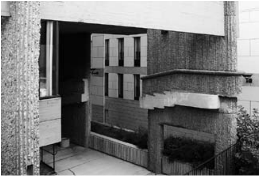
◁ Abb. 4-47: Aufnahmefugen für Fertigteile am Anschluss zum nicht realisierten zweiten Bauabschnitt
