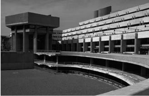
State Service Center, Boston ◁ Abb. 4-46: Innenhof mit teilweise fertiggestellter Tiefgarage (nach 1971)
