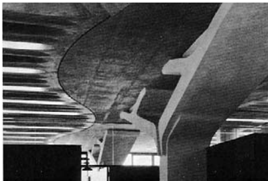
▷ Abb. 3-42: Greely Memorial Forestry Laboratory: Ausbildung von Stützenkopf und Hauptträger
