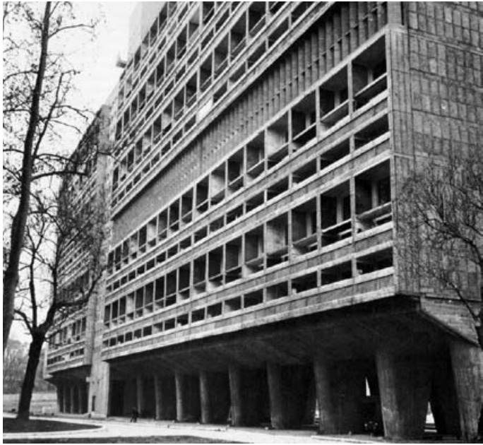
△ Abb. 2-26: Le Corbusier: Unité d'habitation, Marseilles (1945–52)
