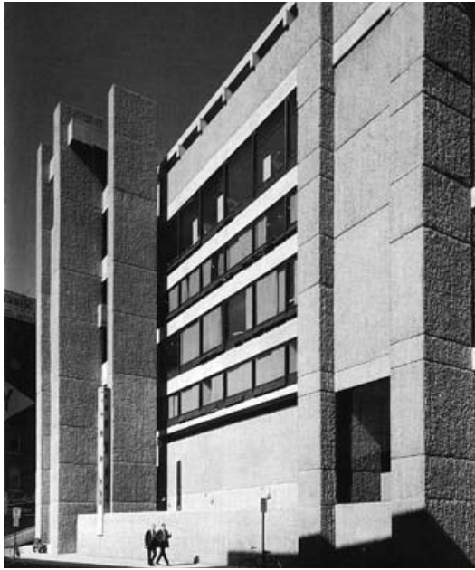
◁ ▽ Abb. 6-5 und 6-6: Fassade an der Chapel Street
