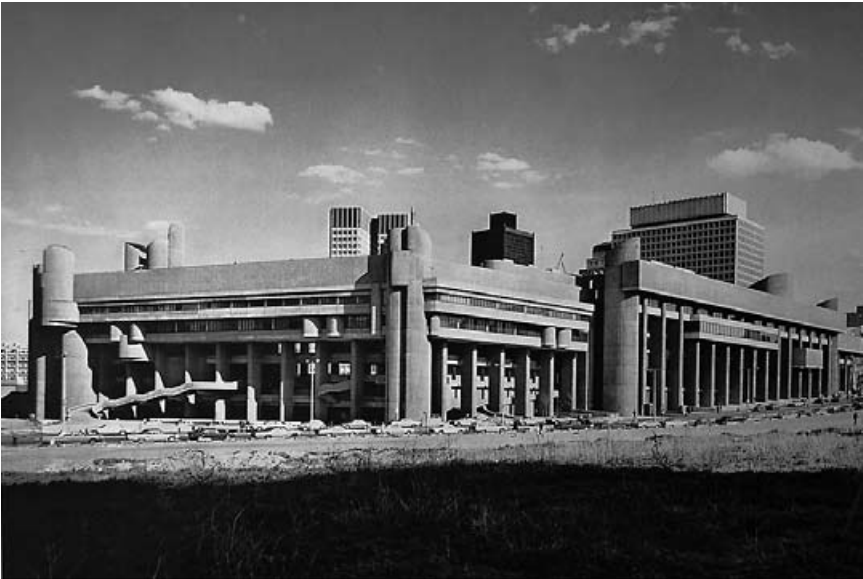
△ Abb. 4-44 und 4-45: Paul Rudolph: State Service Center, Boston, Massachusetts (1963–71). Zustand 1973 nach Einstellung der Bauarbeiten
