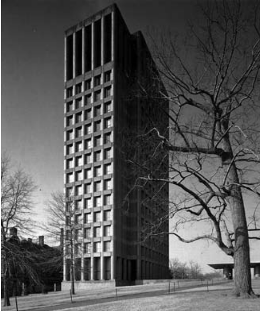
Bauprogramm der Yale University ◁ Abb. 3-33: Philip Johnson und Richard Foster: Kline Science Center (1962–66)
