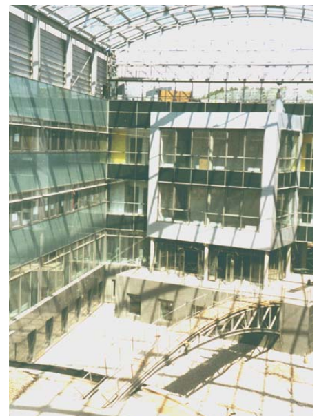
Abb. 8.26 Verwaltungsgebäude Baiersdorf – Lilly, Hamburg Das Y-Glas wird eingesetzt, um Zenitlicht eines überdachten Atriums in die Büroräume umzulenken. [KLEIN 2000 Y9]
