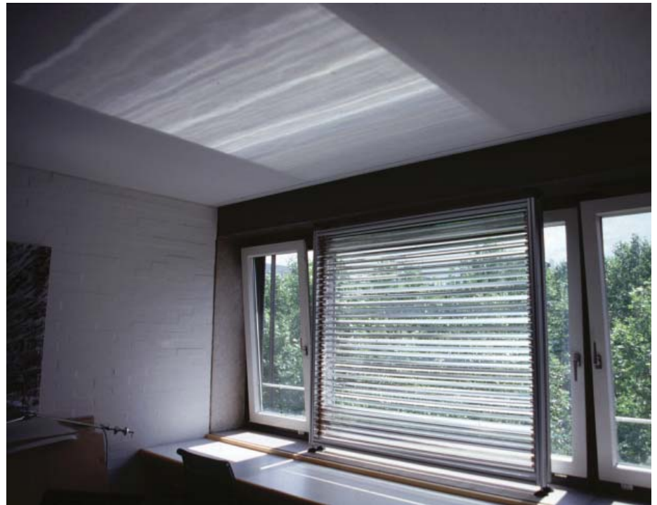
Abb. 10.08 Bürraum mit fensterhohem Fassaden mock-up mit drehbar gelagerten 60°-Prismen
