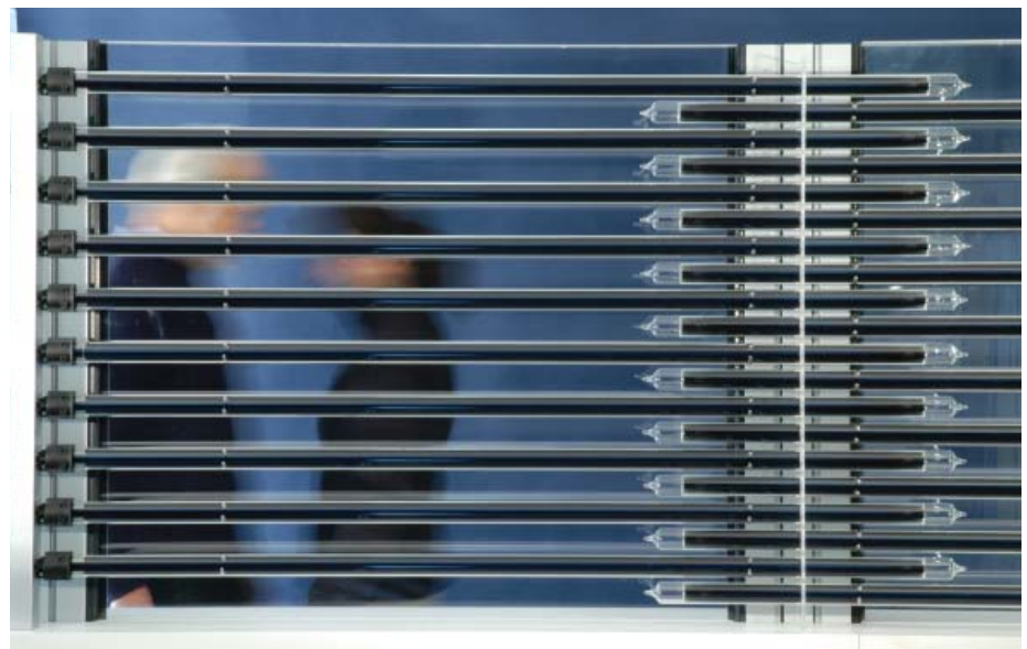
Abb. 9.29 Mock-up mit Teildurchsicht [HEYER]
