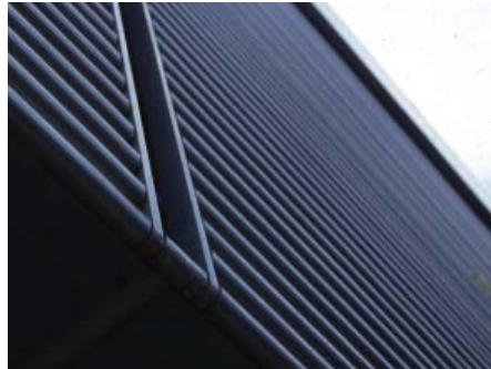
Abb. 2.07 Feststehender Sonnenschutz aus Aluminiumrohren am Reichstag in Berlin. [Foster1]
