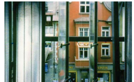
Abb. 8.16 Sparkasse, Bludenz Das Fisch-System ist im Durchsichtsbereich in Form von Öffnungsflügeln eingebaut. Außen ist ein nachführbarer Sonnenschutz aus vertikalen Prismenlamellen angebracht. [KLEIN 2000 F9]
