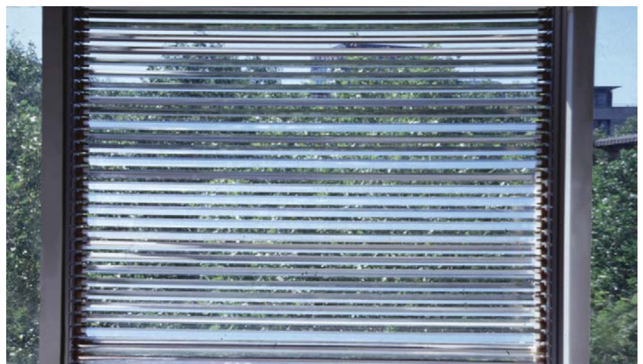
Abb. 10.08 Bürraum mit fensterhohem Fassaden mock-up mit drehbar gelagerten 60°-Prismen
