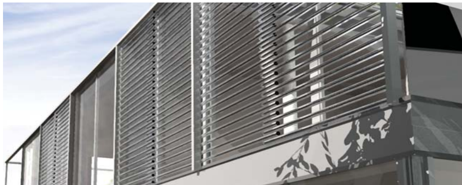
Abb. 9.23 Anordnung der Vakuumröhren in "Kammstruktur"
