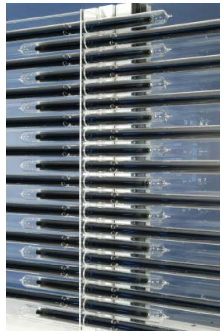
Abb. 9.28 Überschiebungsbereich beim "Kammprinzip" [HEYER]
