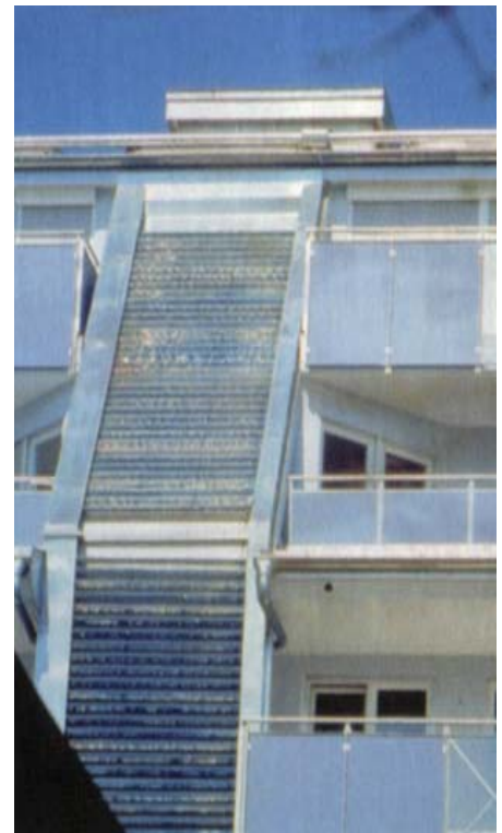
Abb. 9.07 Treppenhaus mit Modulen verkleidet
