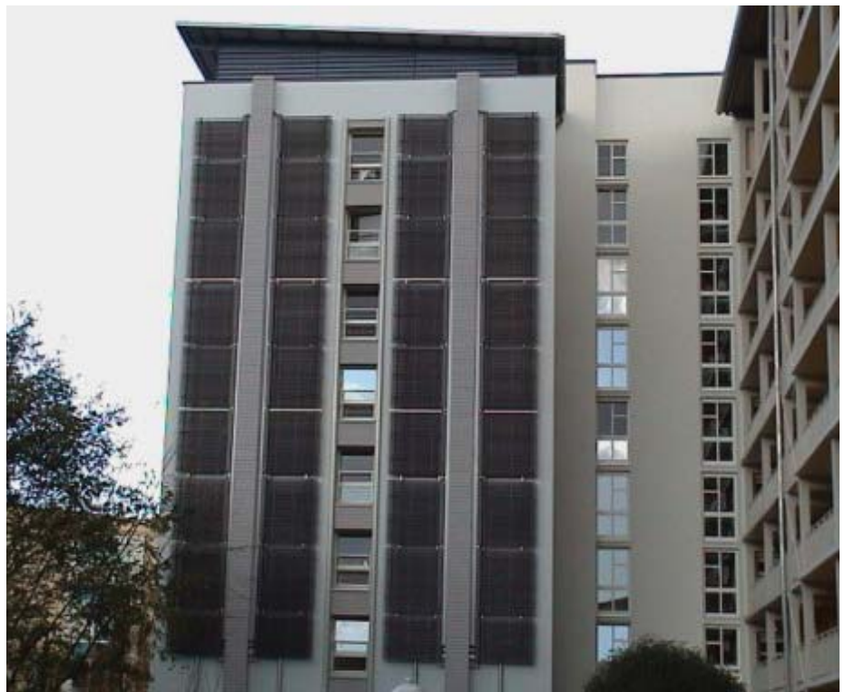
Abb. 9.10 Studentenwohnheim Chemnitz mit thermischer Solaranlage vor der Fassade
