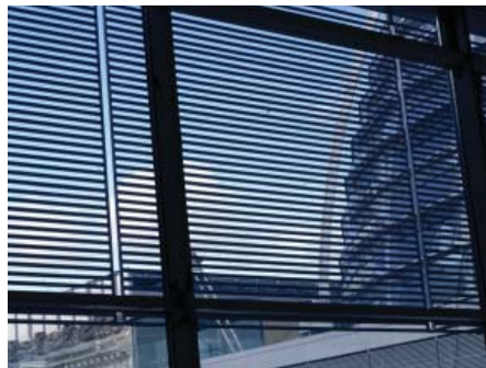
Abb. 2.08 Feststehender Sonnenschutz aus Aluminiumrohren am Reichstag in Berlin, Blick von innen nach aussen. [Foster1]
