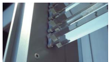
Abb. 10.42 Oberlichtbereich mit Glasprofilen
