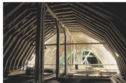
Hauptdach während der Restaurierungsarbeiten.
