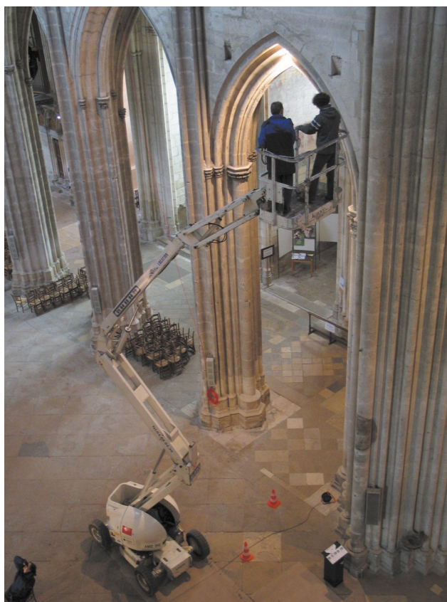
Kartierungsarbeiten im Langhaus.
