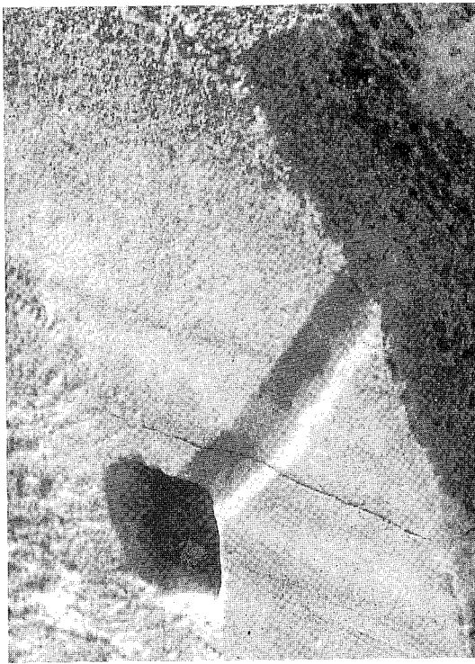
Bild 3: Hohlraum zur Aufnahme der Dollen
