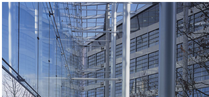
Watertower Place, London – Fassade mit gläsernen Druckstützen.
