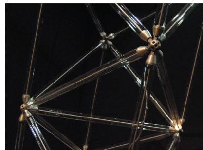
Mero-Raumfachwerk aus Glasrohren.
