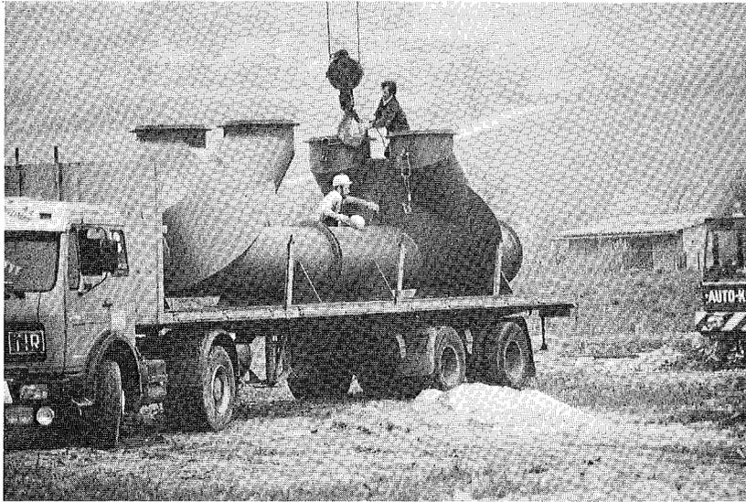
Bild 19 Wirbeldrossel (Grundablaß Alzey)
