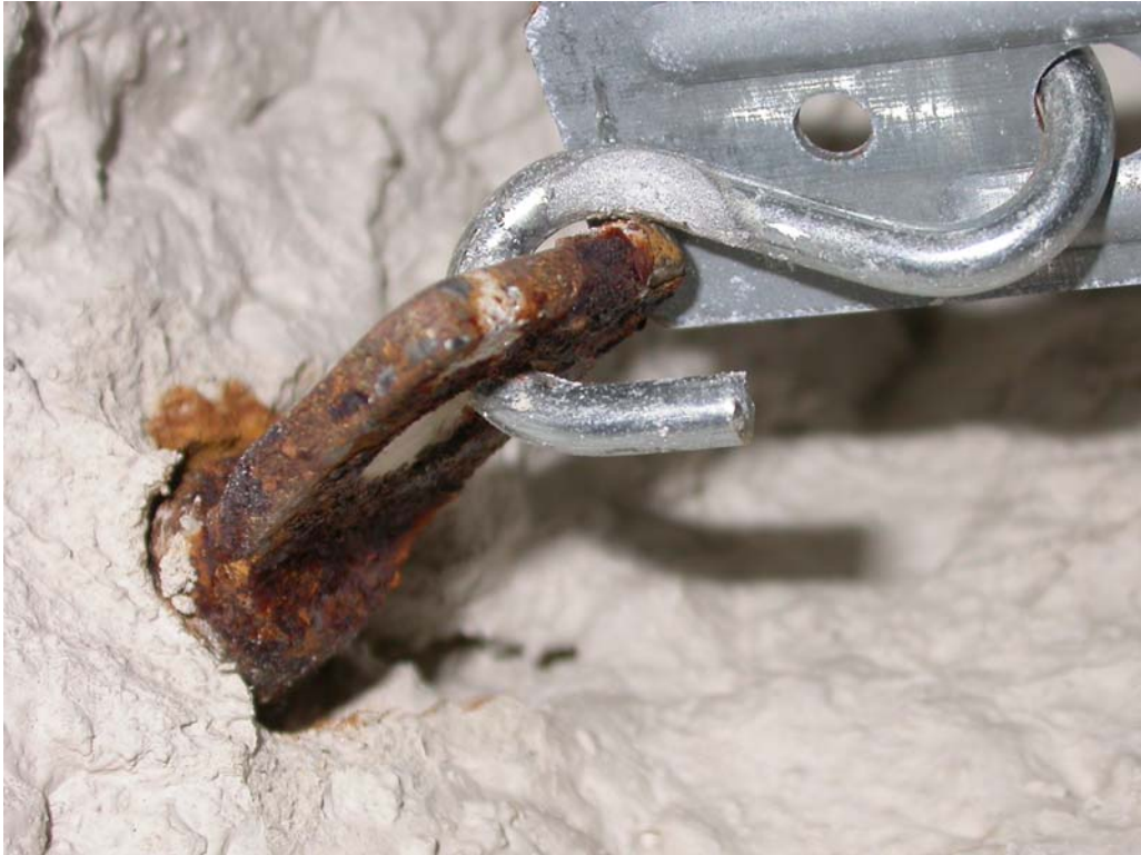
Farbabb. 3: Stark korrodierter verzinkter hochfester Bolzen zur Abhängung einer Klimadecke in Kontakt mit Gips bei unzureichender Austrocknung
