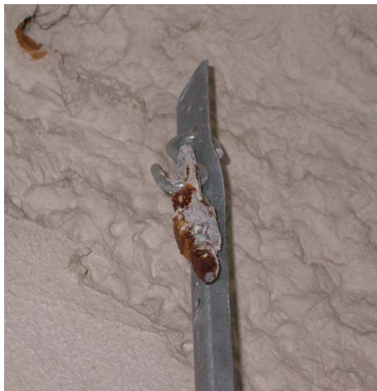
Farbabb. 4: Durch wasserstoffinduzierte Spannungsrisskorrosion gebrochener Bolzen
