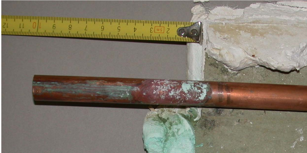
Farbabb. 1: Korrosionsangriff an senkrecht durch Stahlbetondecke geführtes Heizungsrohr aus Kupfer, Deckendurchbruch mit Gips verschlossen
