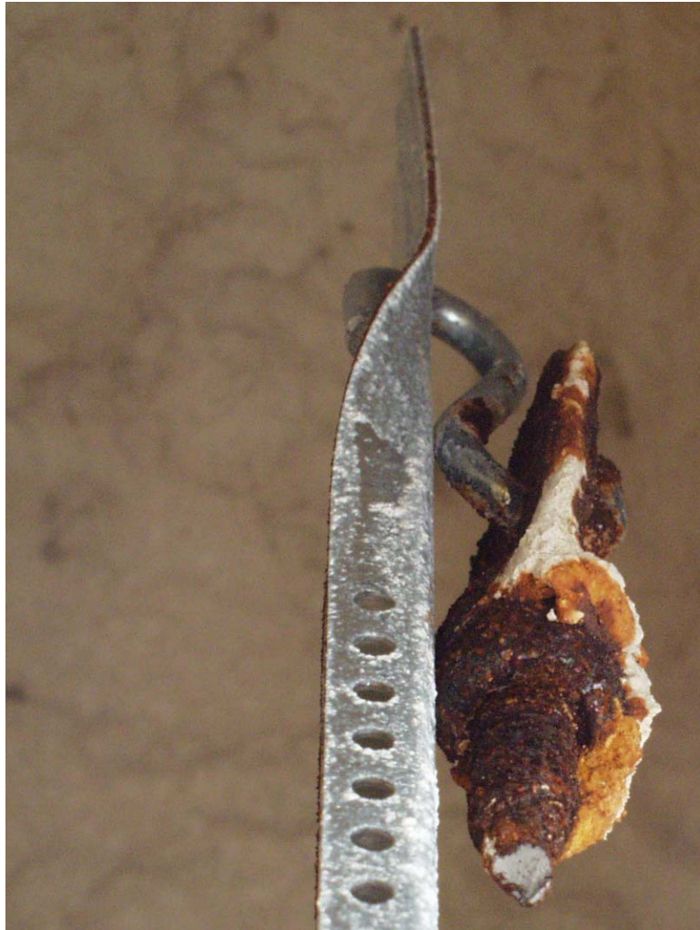
Farbabb. 5: Detailaufnahme des durch wasserstoffinduzierte Spannungsrisskorrosion gebrochenen Bolzens mit charakteristischer Bruchfläche
