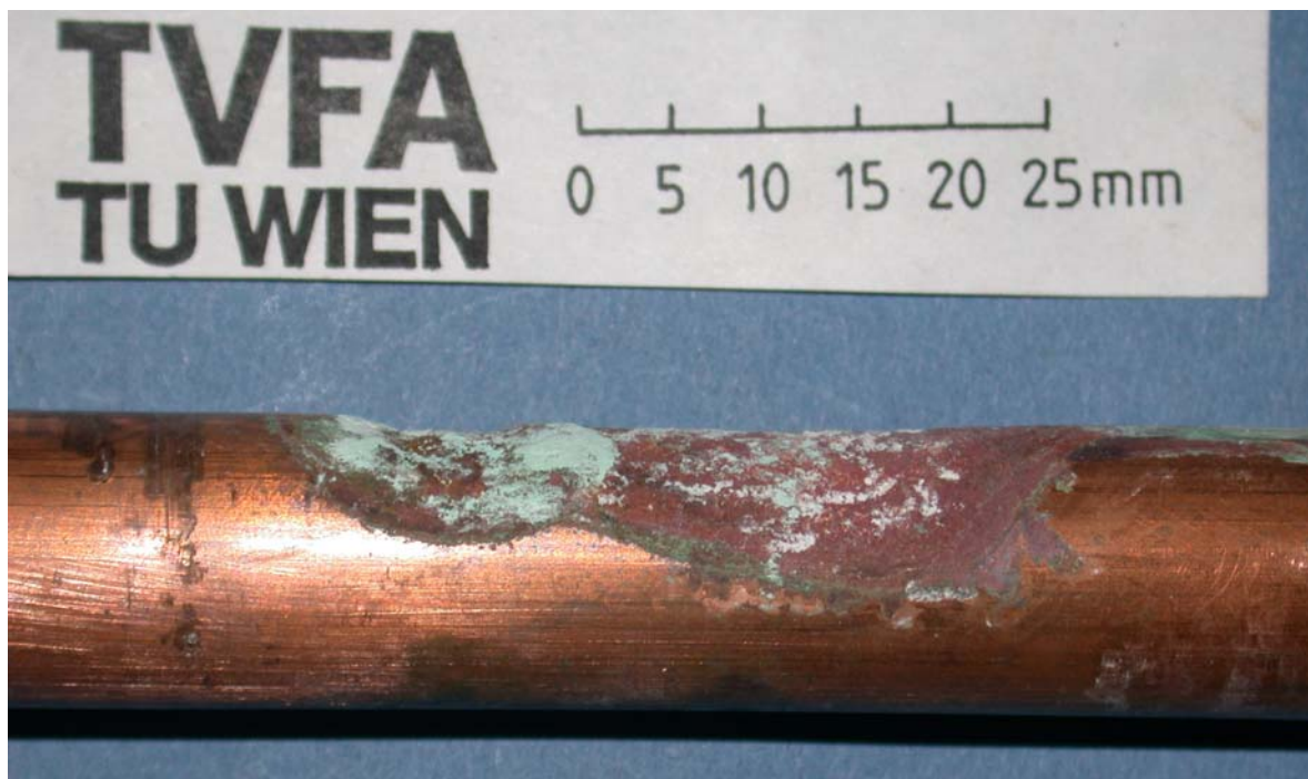
Farbabb. 2: Korrosionsabzehrungen an mit Gips in Kontakt stehendem Bereich des Kupferrohres
