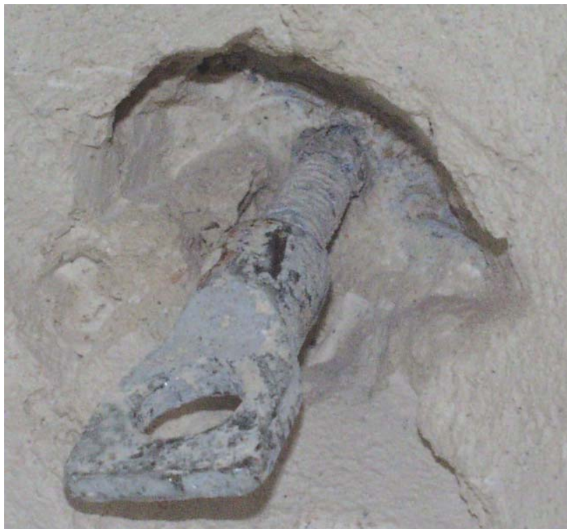
Farbabb. 7: Detailaufnahme des verzinkten hochfesten Bolzens in Kontakt mit Gips bei ausreichender Austrocknungsdauer des Brandschutzgipses
