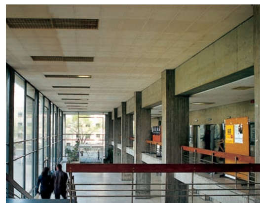
Wo es um die konstruktiv notwendige Aussteifung geht, dominiert in den Kollegiengebäuden Beton.
