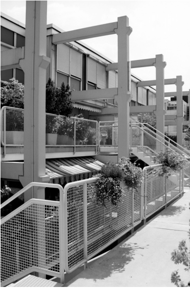
Abb. 5: Erschließungsbrücke zur halbgessossigen Anbindung der Geschosse
