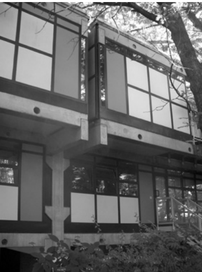
Abb. 14: Fassadendetail mit farbigen Paneelen
