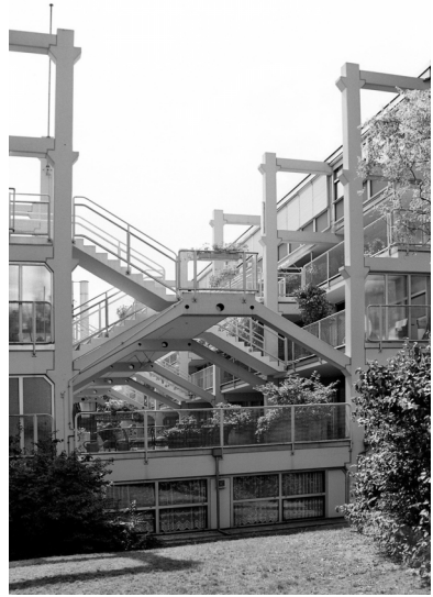
Abb. 6: Halbgessossig versetzte Eingangszone mit vorgelagerten Terrassen
