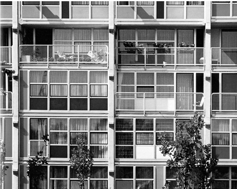
Abb. 9: Fassadenrahmenwerk mit variierender Ausfachung wie unterschiedliche Farbigkeit, Paneele, Fensterteilung und Rücksprünge für Loggien
