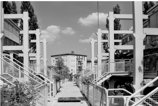
Abb. 4: brückenartige Erschließungsebene mit halbgesschossig versetzten Eingangsbereichen
