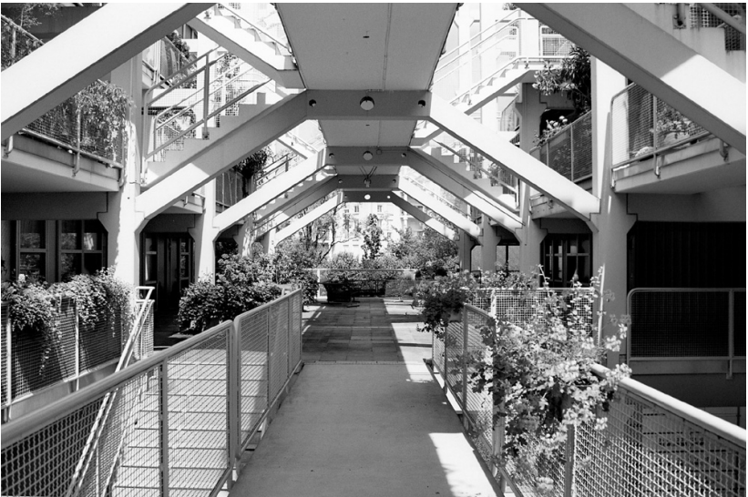
Abb. 7: Ebene unterhalb der Erschließungsbrücke
