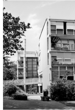
Abb. 1: Eingangsbereich mit Spindelrampe und Aufzugsturm
