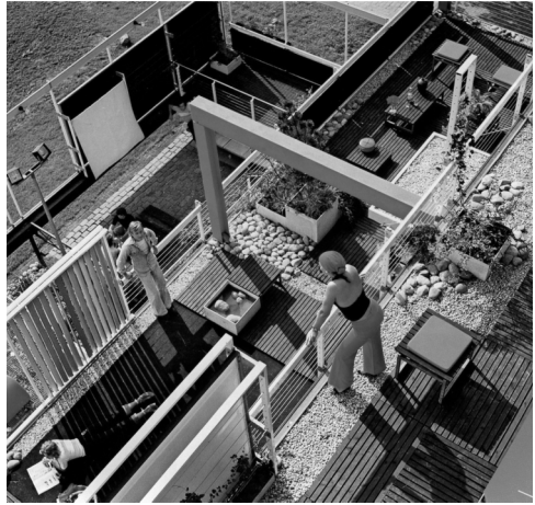
Abb. 8: Abgestimmtes Elementsystem für die flexible Gestaltung der Terrassen aus stapelbaren Holzrosten und Stahlgestellen für Tische, Sitzgelegenheiten, Stufen, etc. in unterschiedlichen Höhenstufen (oben)
