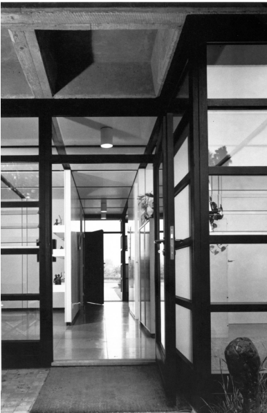
Abb. 16: Eingangsbereich mit sichtbarer Stahlbeton-Kassettendecke im Ausbauraster
