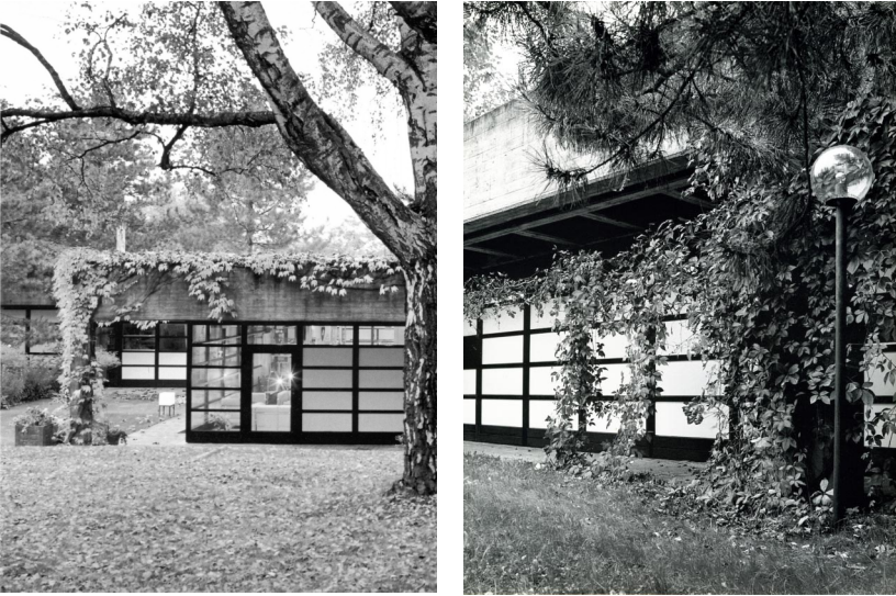
Abb. 12-13: Ecksituation der tischartigen Dachkonstruktion (links), Paneelfassade (rechts)
