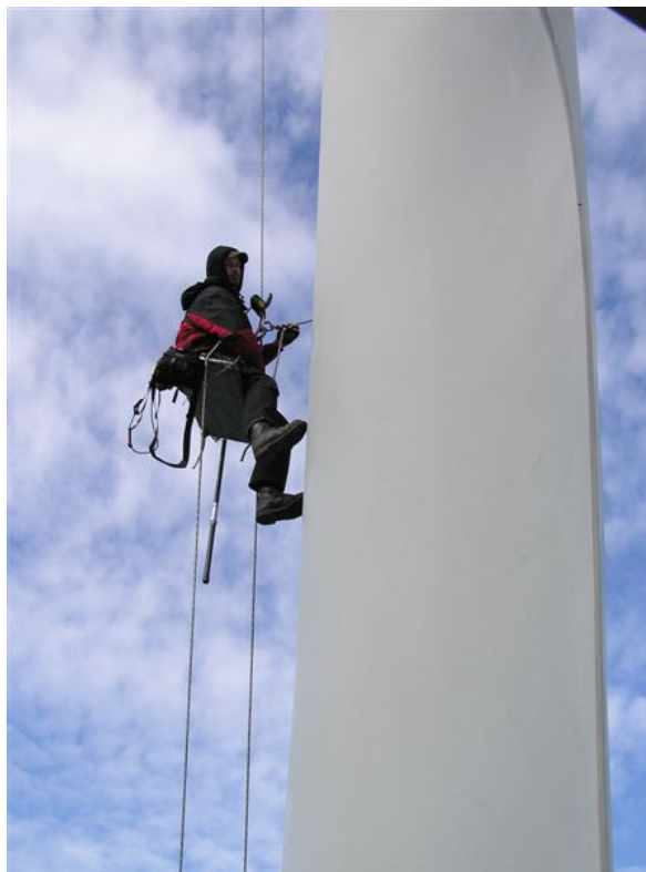
Abbildung 2.4: Begutachtung eines Rotorblattes
