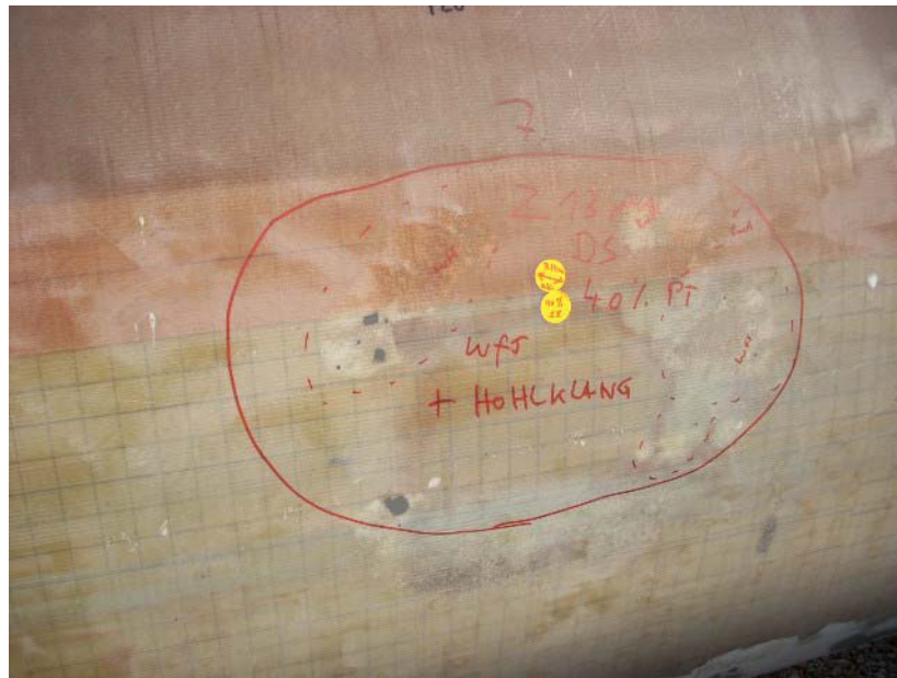
Abbildung 7.11: Markierte Fehlstellen an Messfeld 3.
