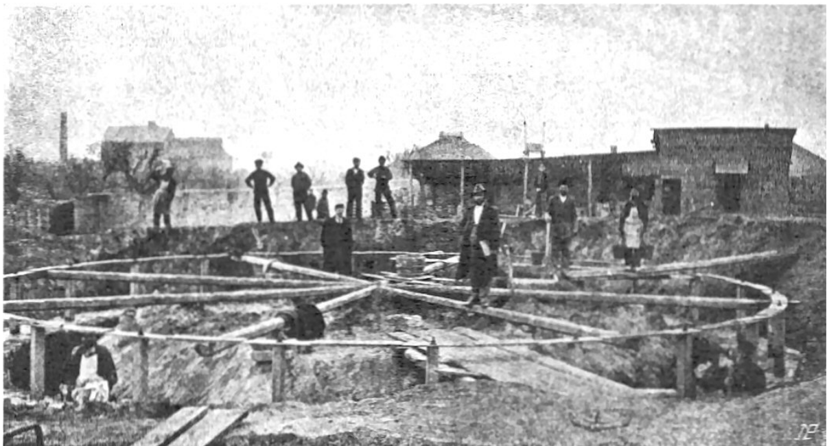
Abb. 4 Abstecken des Fundamentrings des Wasserturms der städtischen Wasserversorgung von Nikolaev. 1906
