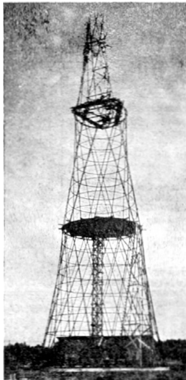
Abb. 8. 69,5 m-Mast. Montage des 3. Abschnitts
