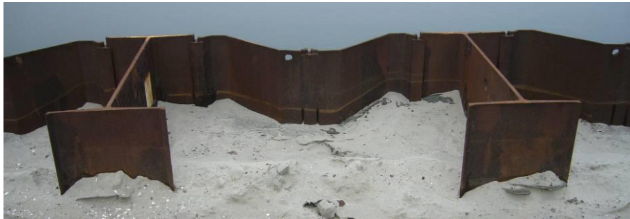
Abbildung 3.9: Foto Einbettung Segment kombinierte Stahlspundwand
