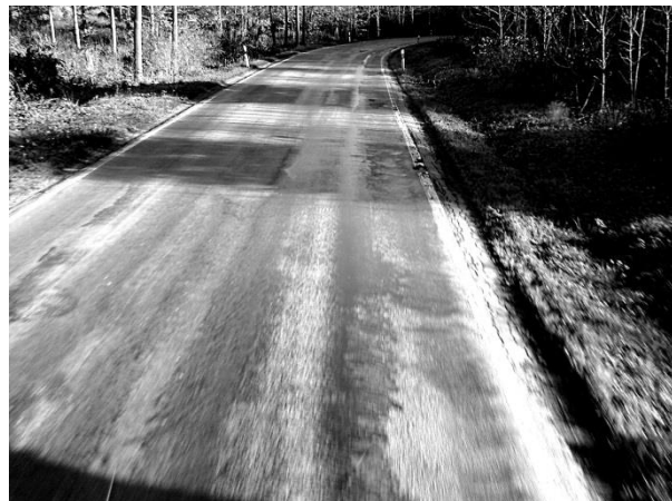
Abbildung 2.4: Beispiel einer Asphaltdeckschicht mit deutlich erkennbarem Schadensbild der Bindemittelanreicherung
