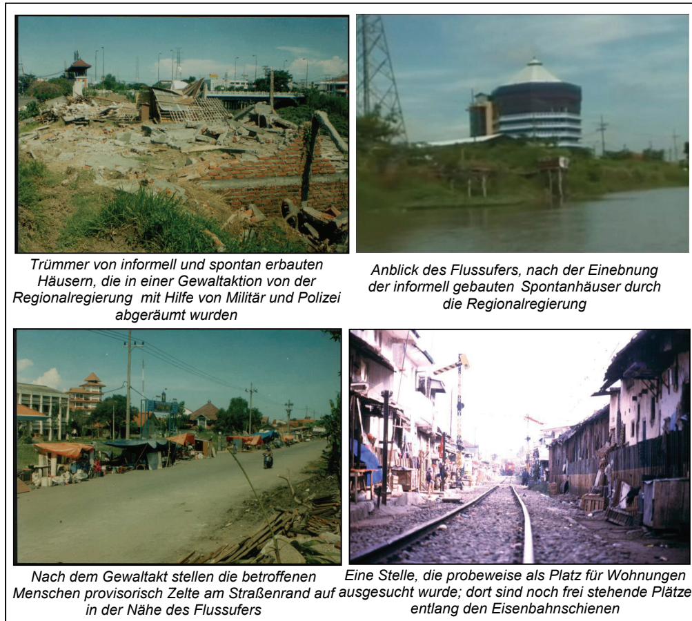
Abbildung IV- 4-6 Zerstörung von Häusern in informellen Siedlungen am Ufer des Wonokromo Kanals
