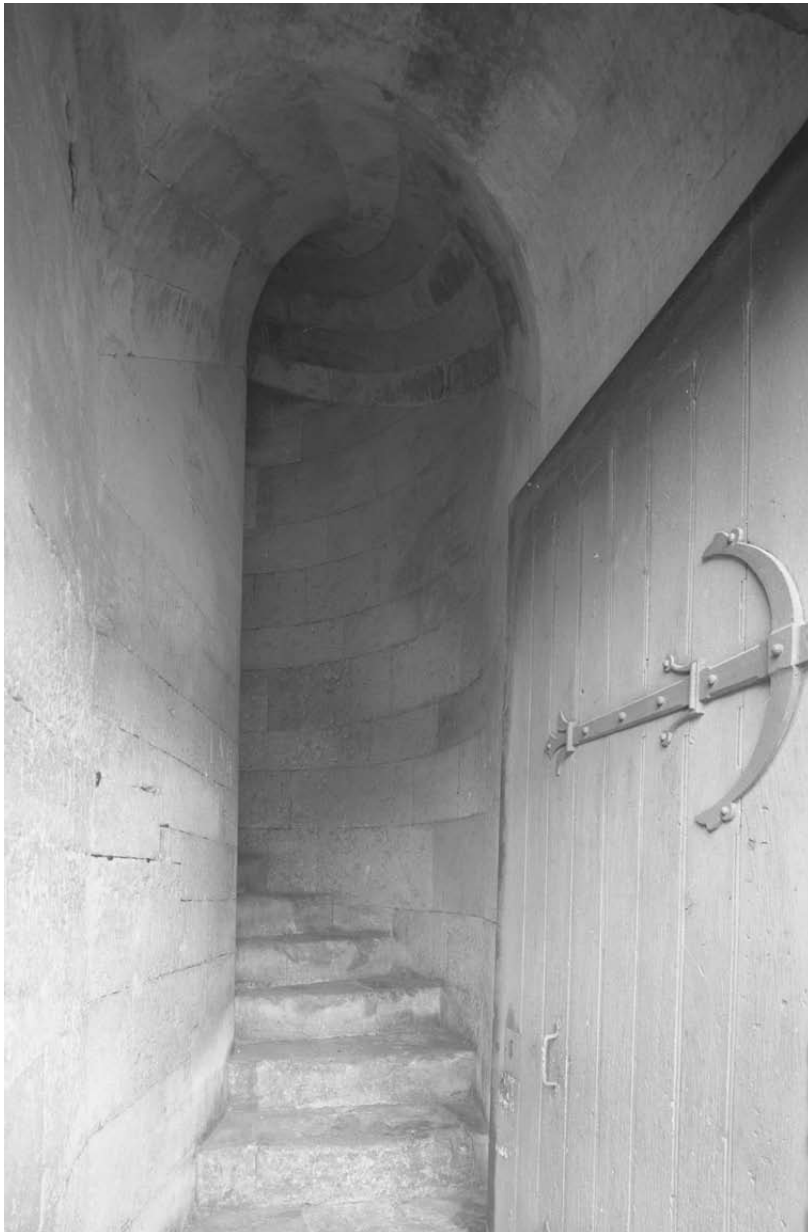
Abb. 73 Chorruinen - Zugang Wendeltreppe in dem Fragment der Nordwand (A. Schlamann) 245
