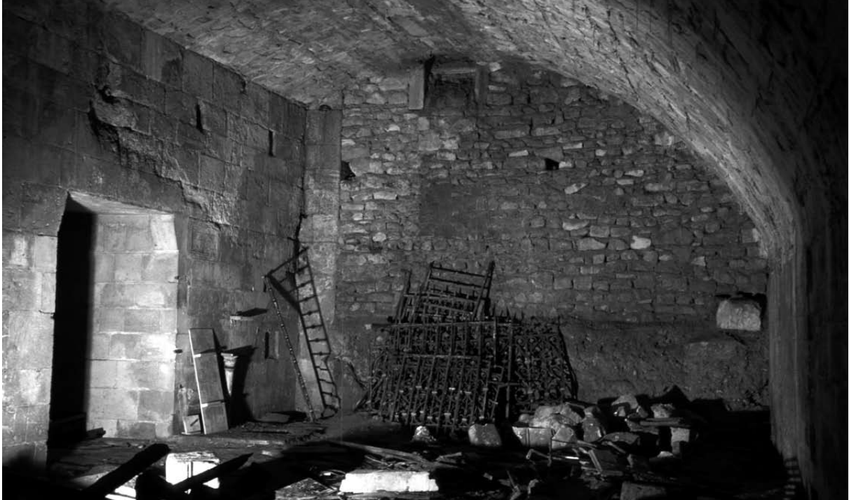
Abb. 90 Raum unter der Treppe Südliche Stirnwand
