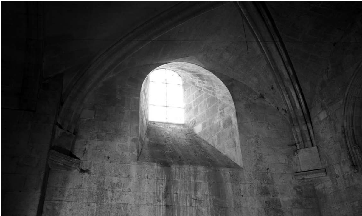
Abb. 94 Westliches Joch der Südwand Zweite, nachträgliche Fensterphase
