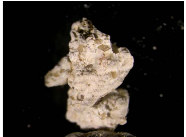
Abb. 1498.Probe 12.1: Kompakter ockerfarbener Kalkmörtel mit Feinsandanteil (Bruchfläche; LM)..
