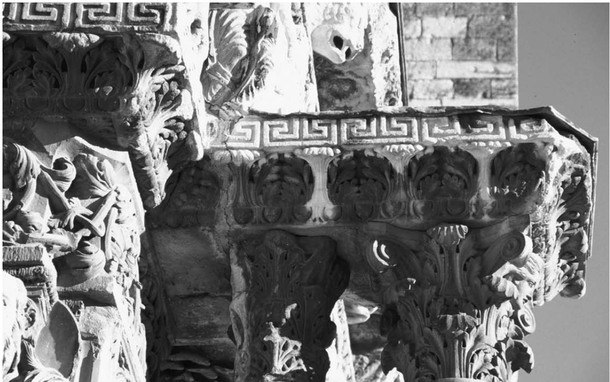
Abb. 105 Kämpferplatte der südlichen Doppelsäulenkonstruktion
