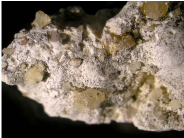
Abb. 1498.Probe 13.1: Oberfläche von Probe 13; Kalkmörtel mit heraus präpariertem Zuschlag (LM).
