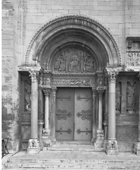
Abb. 56 Nordportal der Westfassade (A. Schlamann)
