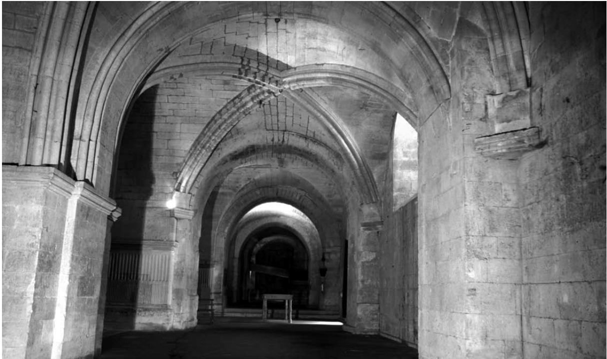
Abb. 92 Südliches Seitenschiff der Krypta mit Blick von Joch I nach Osten Umplanung zu Rippenwölbung
