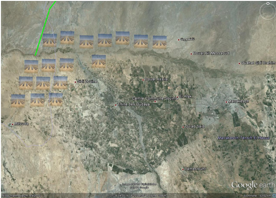
Abbildung 48: Beispiel der 17 x 130 MW Kraftwerke nahe Marrakesch (Google, 2012)
