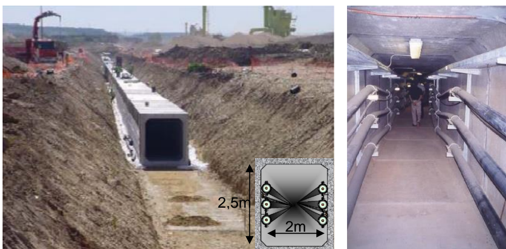
Abbildung 76: Kabeltunnel am Flughafen von Barajas (Madrid)
