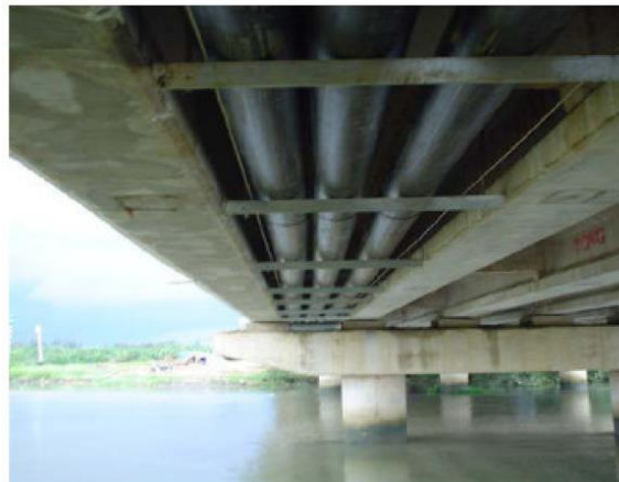
Abbildung 77: Einbau von Kabeln in einem Brückenbauwerk (CESI, 2008)
