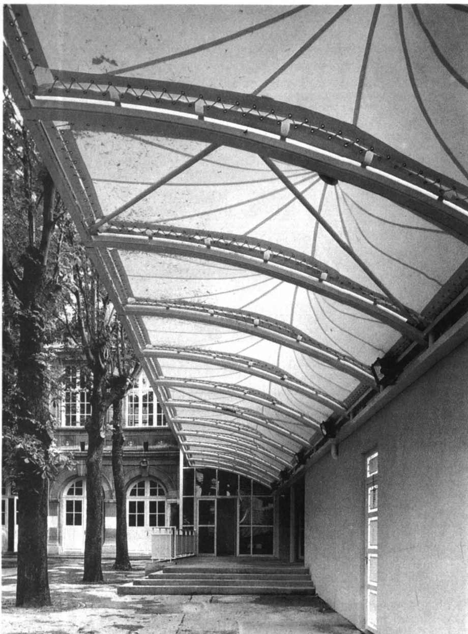
7 Dach über dem Schulhof des Collège Jean Baptiste Clément, Paris; die Überlegung, ein transluzentes Dach für einen Pausenaufenthalt im Trockenen, aber Freien vorzusehen, überzeugt.
