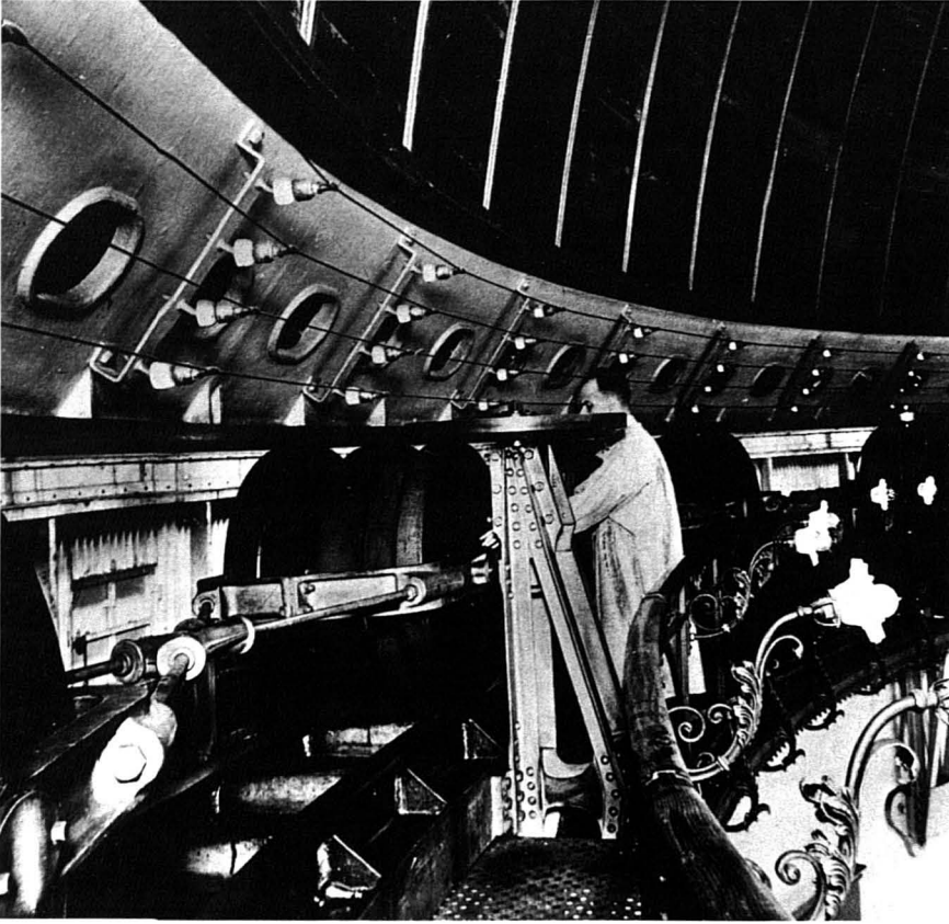
23 Der Rollenkranz, auf dem die große Kuppel drehbar ist, Fotografie, um 1935
