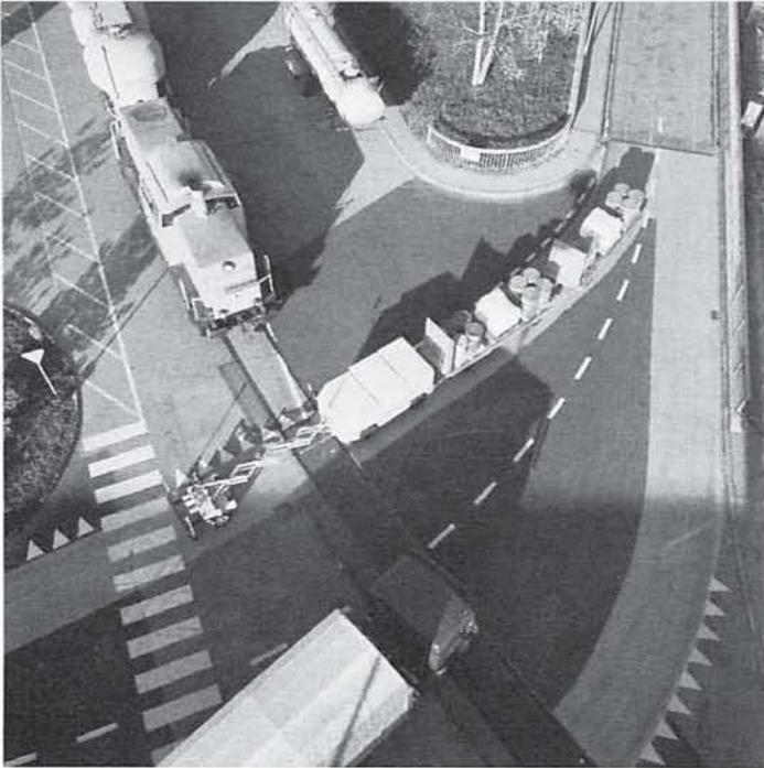
Abb. 2: Den Testeinsatz in der Praxis bestand das Outdoor-FTS für zweimal 4,5 t Nutzlast und 10 km/h Fahrgeschwindigkeit erfolgreich in mehr als 3000 Betriebsstunden im Rahmen eines innerwerklichen Mischverkehrs bei der Ciba Geigy
