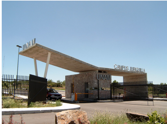
Abb. 6.5.6: Eingangsportal des Campus' Juriquilla der UNAM - U.A.Q
