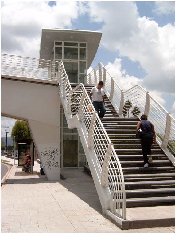
Abb. 5.2.3: Kostspielige, architektonisch anspruchsvolle Brücken mit Behindertenaufzügen an der Carretera libre a Celaya
