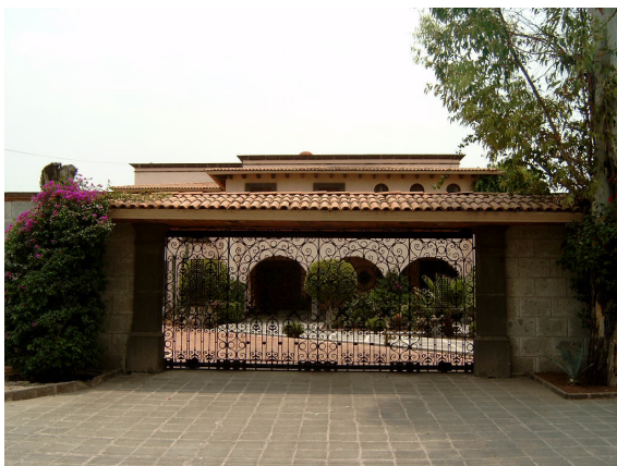
Abb. 6.10.27: Pompös ausgestattete Villa im Vorort Jurica
