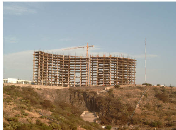
Abb. 6.10.42: Rohbau eines Wohnhochhauses in Milenio III
