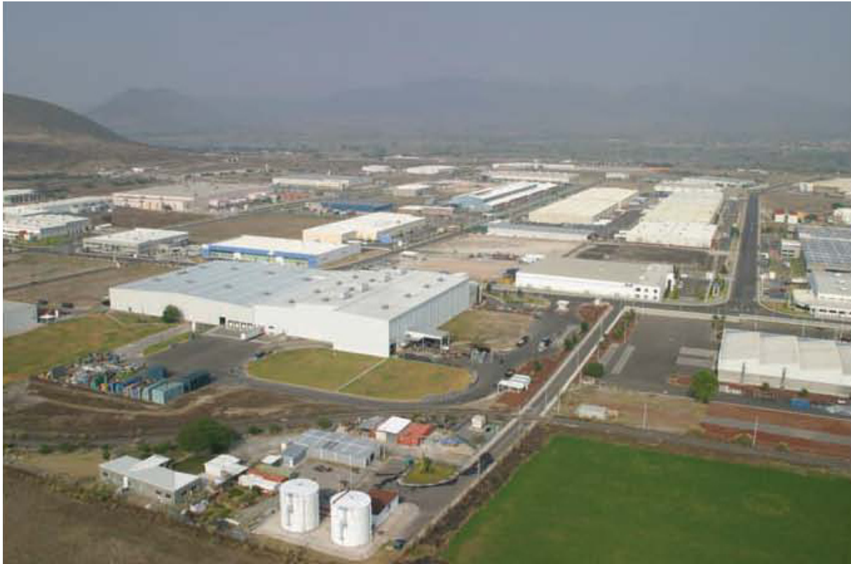
Abb. 6.10.23: In der Peripherie Querétaros liegen modernste Industrieparks mit großflächigen, flachen Produktions- und Lagerhallen
