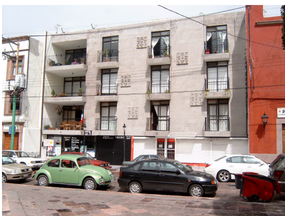
Abb. 6.10.5: ‚Einfühlsame‘ moderne Architektur
