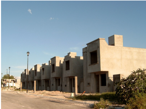
Abb. 9.3.1: Baustelle privater Projektentwickler
