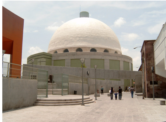
Abb. 6.7.4: Ausstellungsraum für Kinder im Kulturzentrum Manuel Gómez Morín südlich des Parque Alameda Hidalgo
