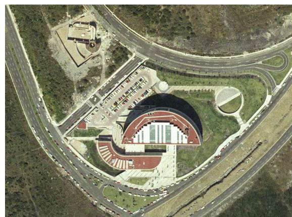
Abb. 6.10.39: Das Centro Civico wurde als eines der ersten Gebäude des geplanten Centros Sur errichtet
