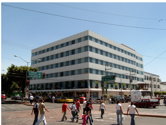
Abb. 6.9.15: Hotelbau östlich des Alamedaparks
