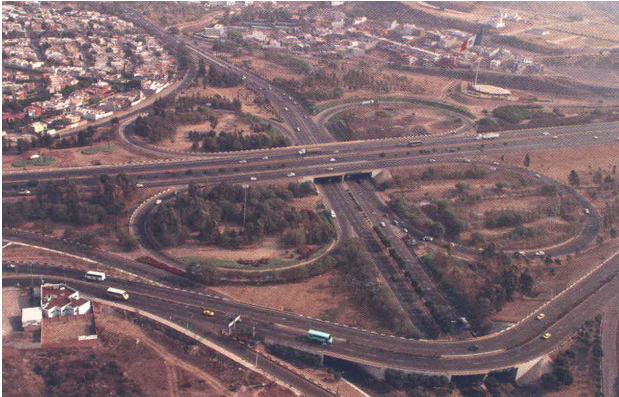
Abb. 7.1.3: Raumgreifendes Autobahnkleeblatt am östlichen Stadteingang
