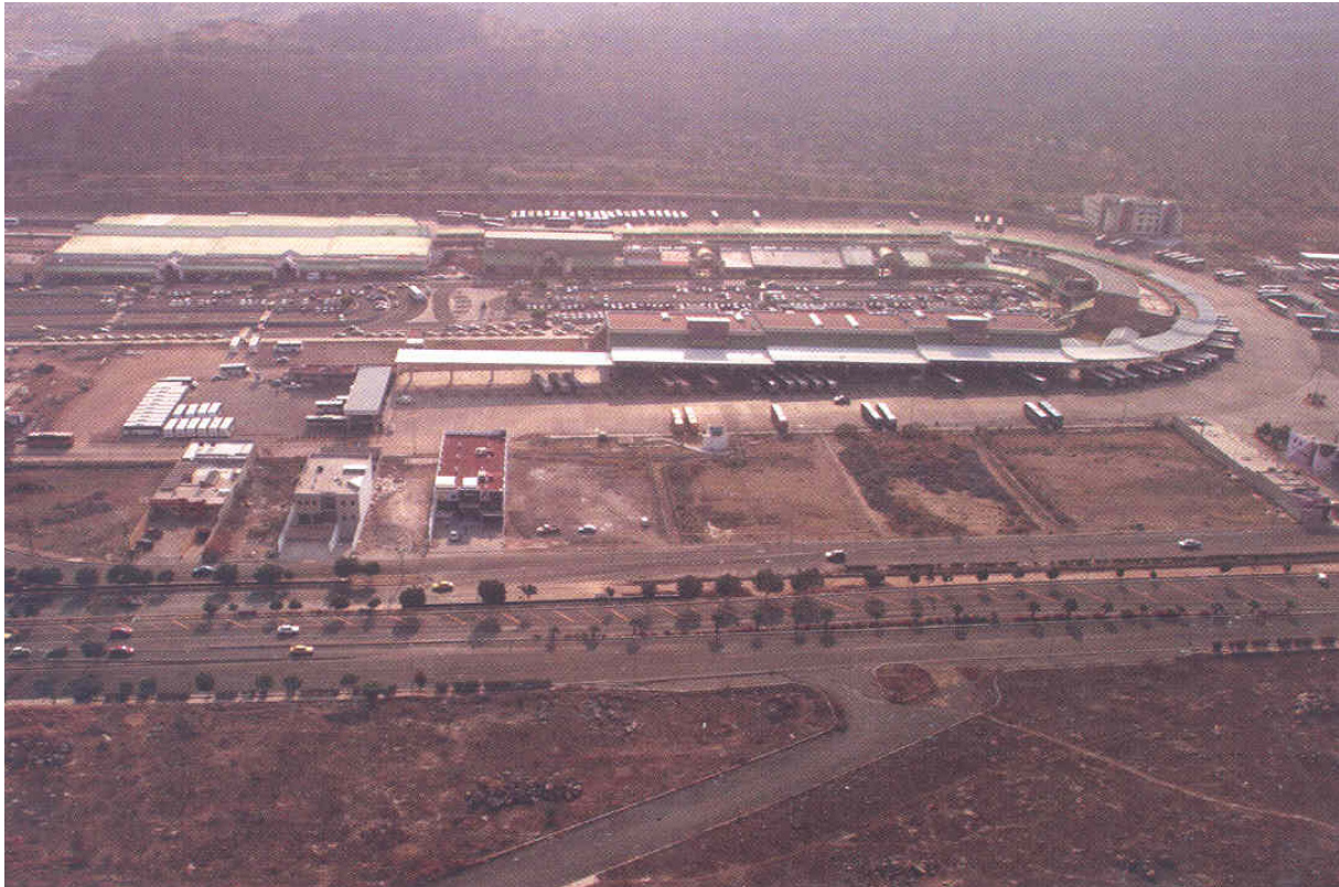
Abb. 7.2.3: Terminal de Autobuses de Querétaro (TAQ)
