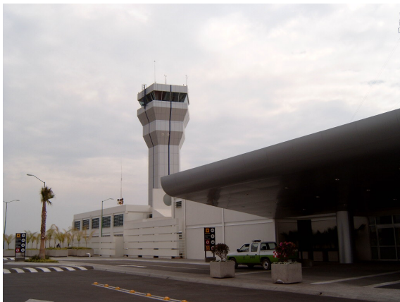
Abb. 6.10.36: Eingangsfront und Turm des neuen Flughafens
