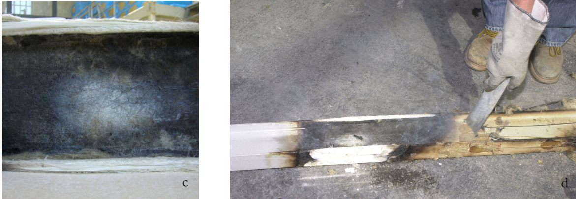
Abb. 9.33 c) Schwarze Einfärbungen der freiliegenden Fasern durch Pyrolysegase, d) von Steinwolle befreiter Träger mit vollkommenen Zersetzungsbereich der oberen und unteren Flansche
