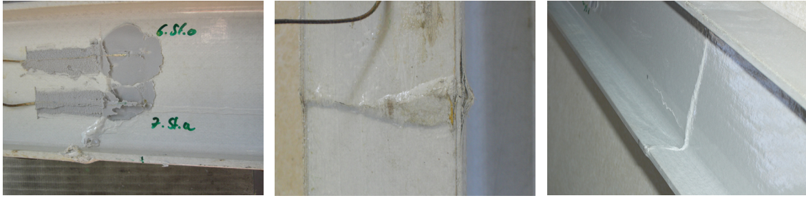
Abb. 9.24 Bruchbilder vom Druckflansch der IPE-120-Biegeträger
