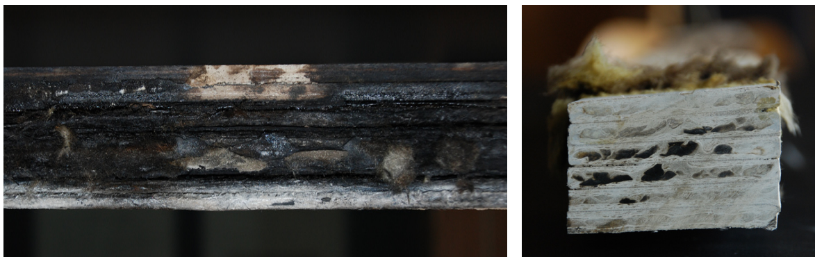
Abb. 10.19 Thermische Schädigung der Seitenansicht und Verfärbungen am Querschnitt des Profilendes
