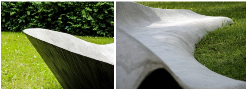
Abbildung 71: Nahaufnahmen der verlorenen Sandwichverbundschalung und der Betonoberfläche
