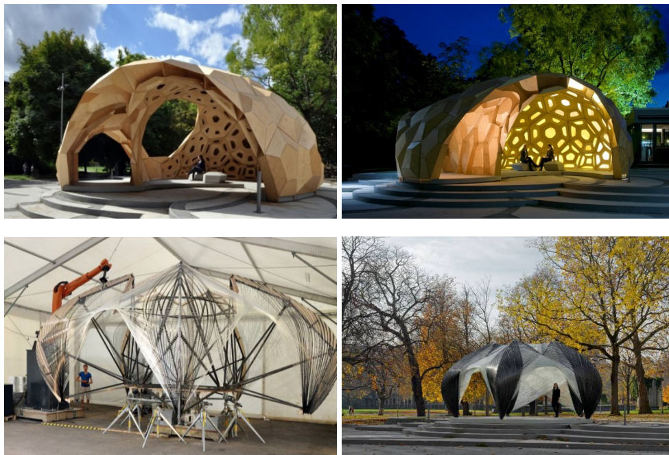
Abbildung 9: ICD/ITKE Forschungspavillon 2011 und 2012: Beispiel eines integrativen Planungsprozess [14][15]
