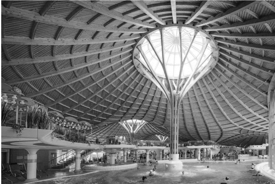
Figure 1.3: The brine bath in Bad Dür rheim is a good example for showing the efficiency and the geometric variety of timber shell structures. (Kur- und Bäder GmbH Bad Dür rheim, http://www.db-bauzeitung.de/150-jahre-db/in-die-jahre-gekommen-zum-db-jubilaem/#slider-intro-2 )
