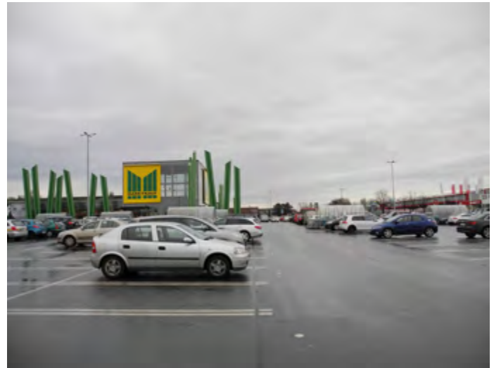
Abb. 43 Großflächig asphaltierte Parkplätze vor einem Verbrauchermarkt (ILPÖ 2016)
