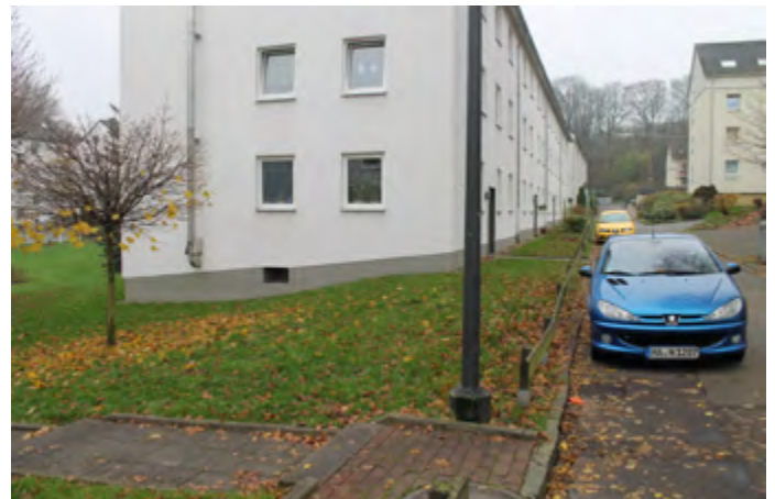
Abb. 122 Der Zeilenbau der Genossenschaft steht quer zur Fließrichtung des Regenwasser. Im Starkregenfall kumuliert das Regenwasser aus dem Kanalnetz mit dem oberflächigen Wasser und fließt unkontrolliert am Gebäude entlang in den Innenhof der Genossenschaftssiedlung (ILPÖ 2013)
