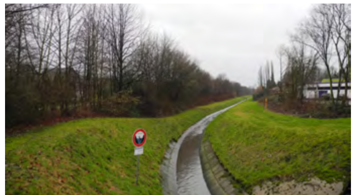
Abb. 36 Der derzeit als Abwasserkanal genutzte Lanferbach (ILPÖ 2016)
