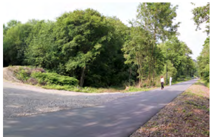
Abb. 109 Durch ein Drosselbauwerk in der verrohrten Varresbeck wird die Überflutung von dem Gewerbegrundstück in die natürliche Mulde links neben der Nordbahntrasse verlagert (ILPÖ 2016)
