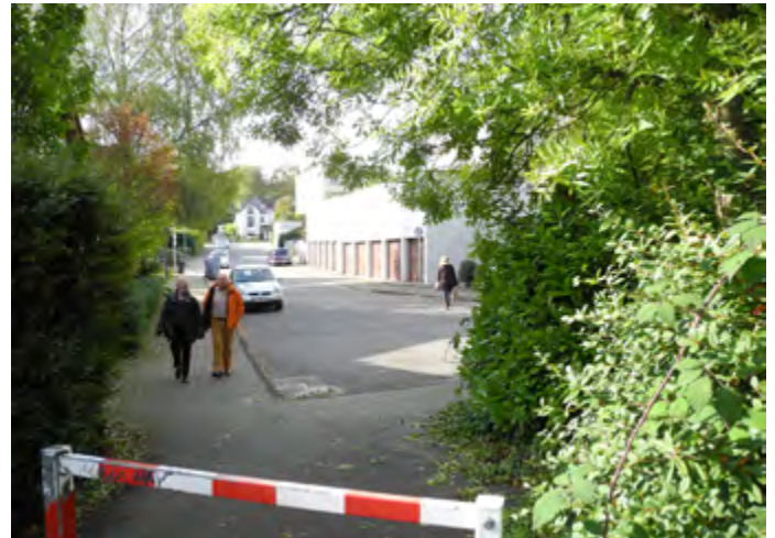
Abb. 116 An diesem in einer Senke liegenden Straßeneinlauf (Bereich A) kommt es im Starkregenfall zu Überstau und Überflutung der Straße (ILPÖ 2013)
