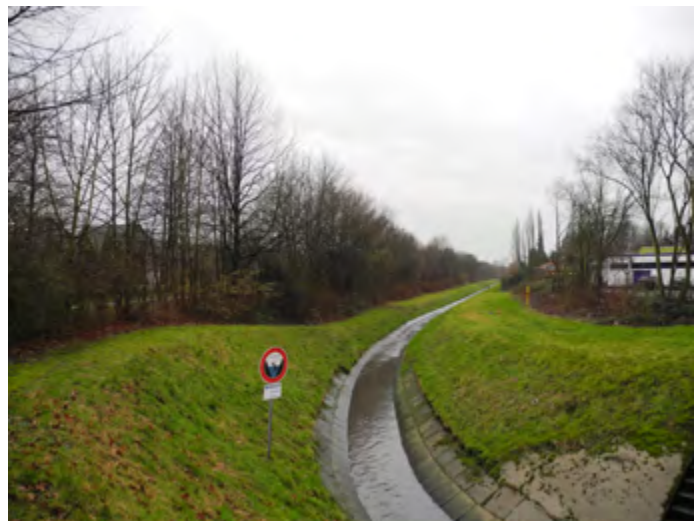
Abb. 57 Der als Abwasserkanal genutzte Lanferbach (ILPÖ 2016)
