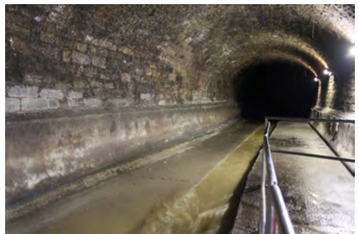
Abb. 11 Mit Trinkwasser gespeiste Brunnenanlage im mittleren Schlossgarten, Stuttgart. Darunter verläuft der ins Mischsystem integrierte Nesenbach (oben Deister 2015, unten Bachmann 2015)
