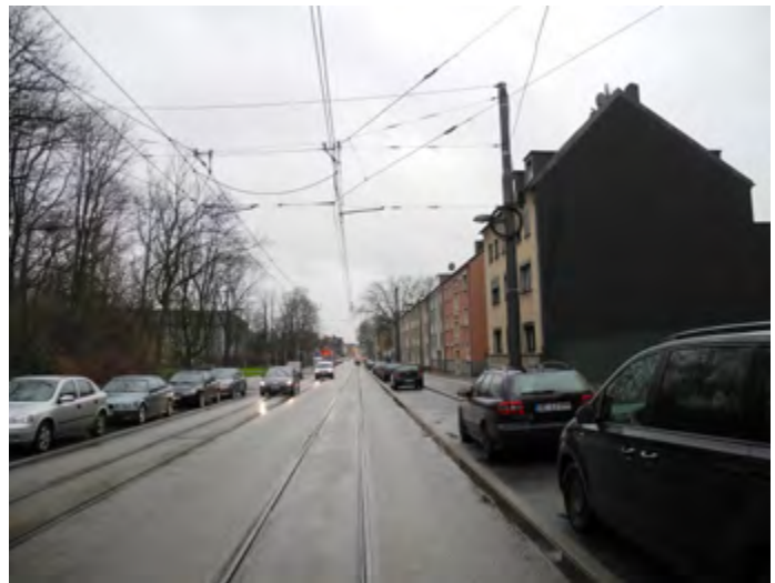
Abb. 56 Die Horster Straße mit beidseitigen Parkieranlagen (ILPÖ 2016)
