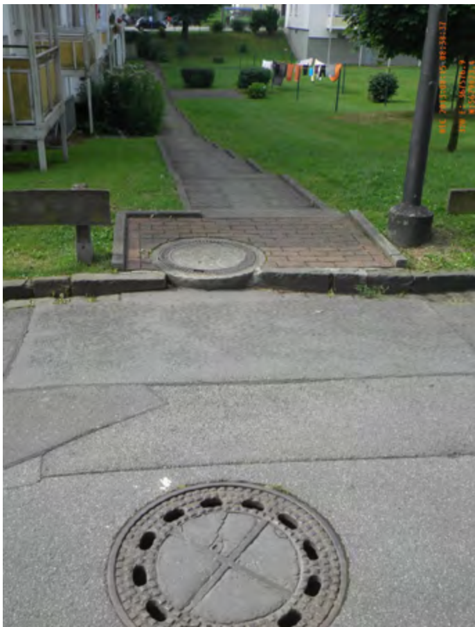
Abb. 125 Durch den ungünstigen Verlauf des Kanalnetzes kommt es im Starkregenfall zu Überstau (Dr. Pecher AG 2013)
