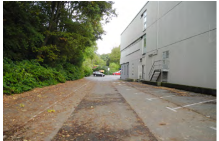
Abb. 107 Der Parkplatz des Gewerbegrundstücks wird bei Starkregenereignissen überflutet und das Regenwasser fließt in das Gebäude (ILPÖ 2013)
