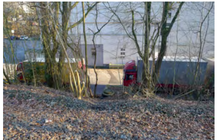
Abb. 108 Blick auf das Gewerbegrundstück von der Nordbahntrasse aus. Das Kanalnetz verläuft an dem Schachtbauwerk 90° nach rechts. Das führt häufig zu Überstau im Starkregenfall (ILPÖ 2014)
