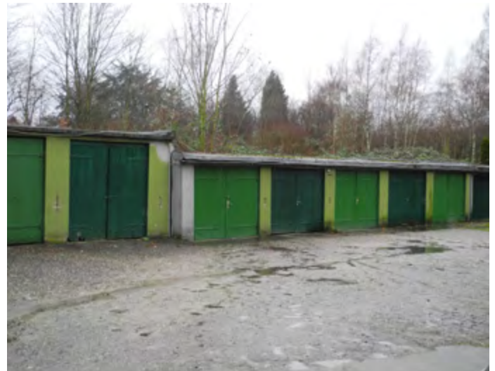
Abb. 71 Die Innenhöfe der Blockbebauung sind oft asphaltiert und beherbergen Garagen mit Flachdächern (ILPÖ 2016)
