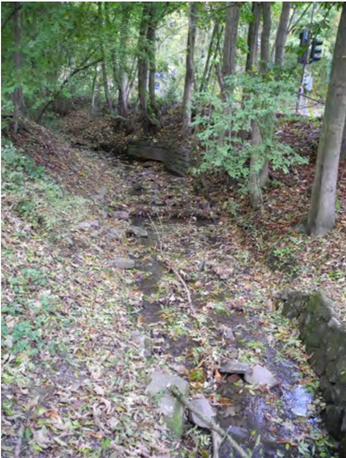
Abb. 87 In Teilen verläuft die Varresbeck als Hauptgewässer im gleichnamigen Stadtbezirk noch unverrohrt. An anderen Stellen ist sie in das Regenwasserkanalnetz verfächert (ILPÖ 2013)
