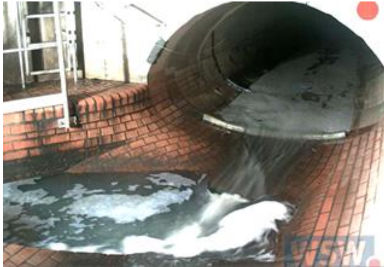
Abbildung 19: Detektion von Fehleinleitungen (Schaum deutet auf häusliches/gewerbliches Abwasser hin) in einen verrohrten Bachkanal an einem qualitätsabhängig gesteuerten Bauwerk und Ableitung zu Behandlung im ESW-RÜB-Kläranlage (Kamera wird über Qualitätsmessung aktiviert)
