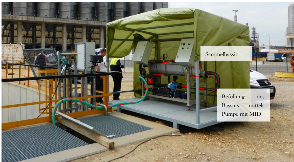
Abbildung 5: Bypass-Installation, seitlich befülltes Bassin (Quelle: TU Graz)
