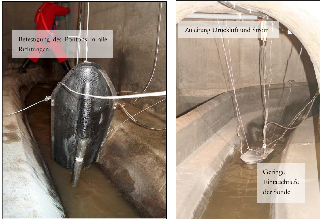
Abbildung 8: Schwimmende Installation (Quelle: TU Graz)
