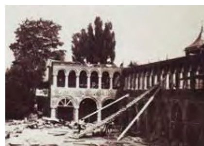
127. Mogoșoia, Baustelle der Villa Elchingen, 1920er Jahre.
