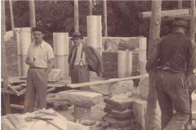
249. Baustelle der Kirche Flămânda [Die Hungerige] (W 71), Aufnahme vom 22. August 1938.
