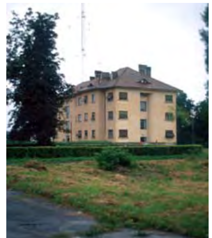
WV 123. GMC, Rundfunkstation Brenndorf, Mechaniker-Wohnhaus (2). Aufnahme 2006.
