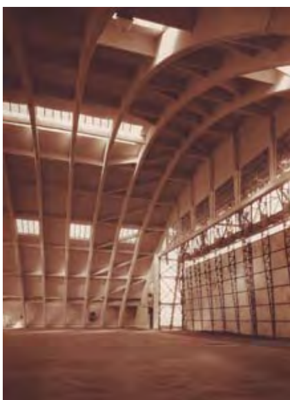
WV 89. I.A.R. Flugzeugwerk, Kronstadt, Innenansicht des Hangars, 1930er Jahre.
