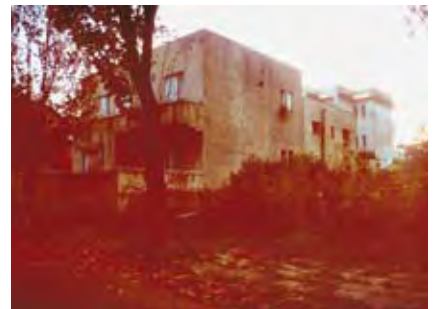
WV 113. Villa Z, Ansicht von Nordosten. Aufnahme 2006.
