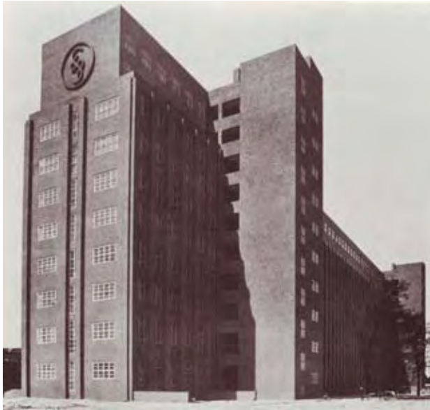
319. Hans Hertlein, Schaltwerk-Hochhaus, Siemensstadt Berlin (1928). Ansicht von Südosten (Aufnahme 1928).
