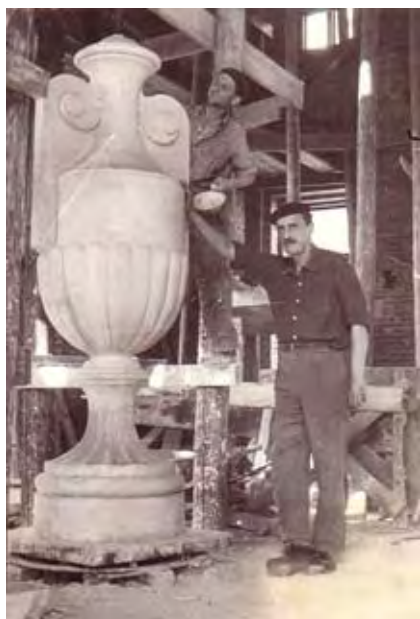
366. Metropole-Baustelle, Bauarbeiter und GMC. Aufnahme o. D. [1960].
