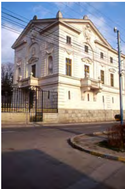
WV 226. Metropolie-Erweiterung, Jassy, südlicher Zwillingspavillon. Aufnahme 2007.
