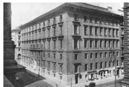
166. Otto Wagner, Wohn- und Geschäftshaus Stadiongasse Nr. 6/8, Wien (1881-1883). Eckansicht.
