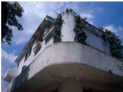
WV 107. Villa Flora, Südostecke. Aufnahme 2008.
