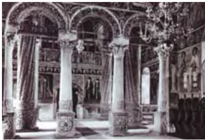
WV 30. Klosterkirche Văcărești, Blick aus dem Naos in den Pronaos auf die Säulen mit spiralförmigem Beschlagwerk. Aufnahme 1930er Jahre.
