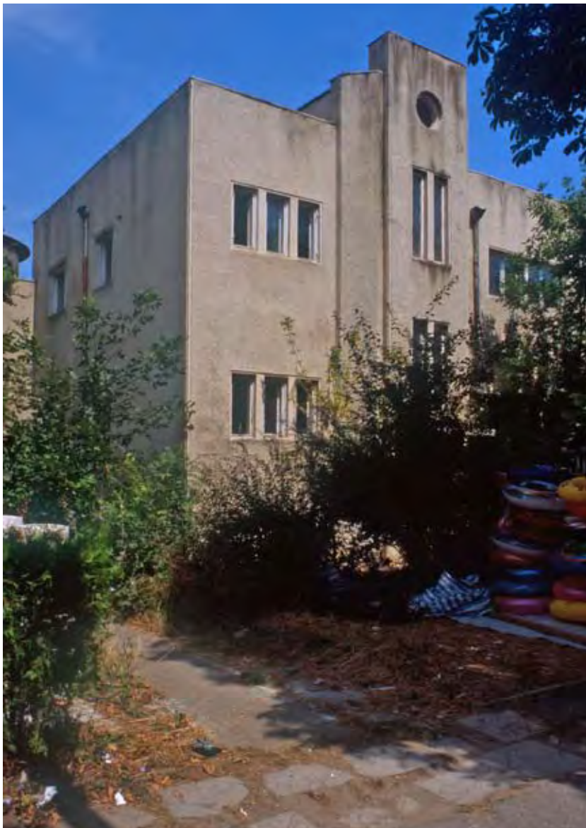
WV 112. Villa Z, Ansicht von Südwesten. Aufnahme 2008.
