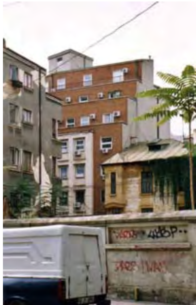
WV 210. Bürogebäude Str. Vasile Lascăr. Aufnahme 2007.
