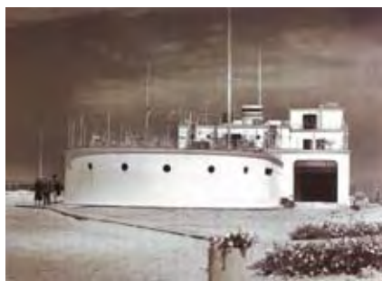
421. Bootsbaus , Mamaia (WV, W 50, GMC zugeschrieben), zerstört 1960. Rückansicht.
