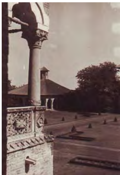
129. Mogoșoaia, Blick auf die südliche Söllerecke. Im Hintergrund die ehemalige Küche (historische Aufnahme).
