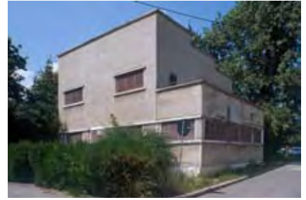
WV 102. Blaue Villa, Ansicht von Südosten. Aufnahme 2008.
