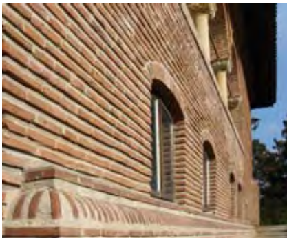
339. GMC, Konak Drugănești (1939-1946), Sockelbereich der Südfassade.
