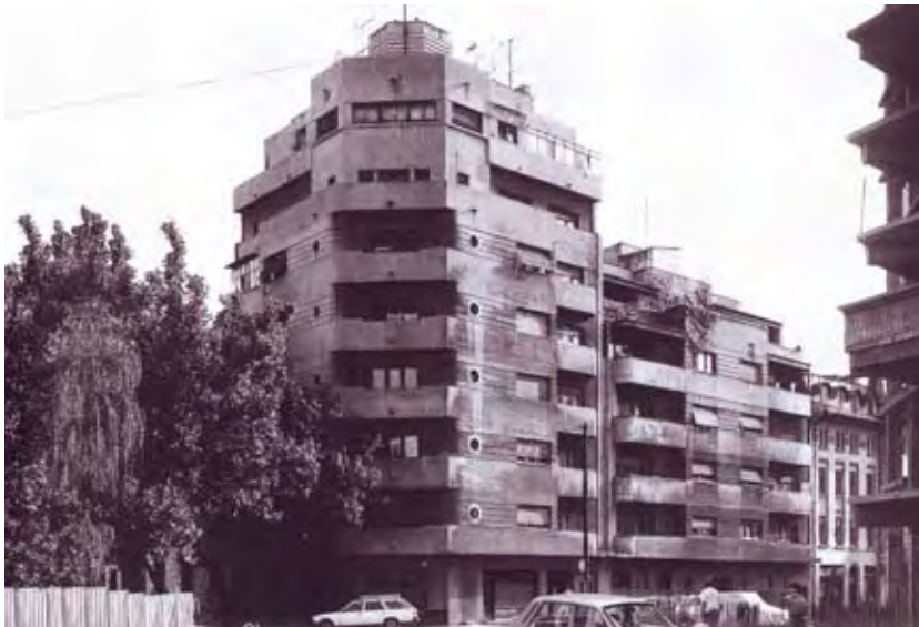
WV 137. Appartementgebäude Str. Vânători 1 und 1bis. Aufnahme Armin Kley/Berlin, 1996.
