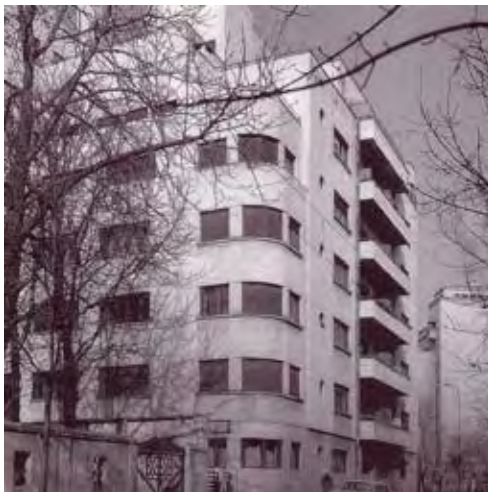
WV 128. Appartementgebäude Bragadiru, Südostecke. Aufnahme 1990er Jahre.
