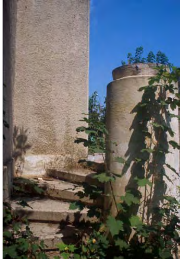
233. Eforie, Villa Z (WV, W 39, vom Verfasser GMC zugeschrieben). Aufgang zur Terrasse. Aufnahme 2008.
