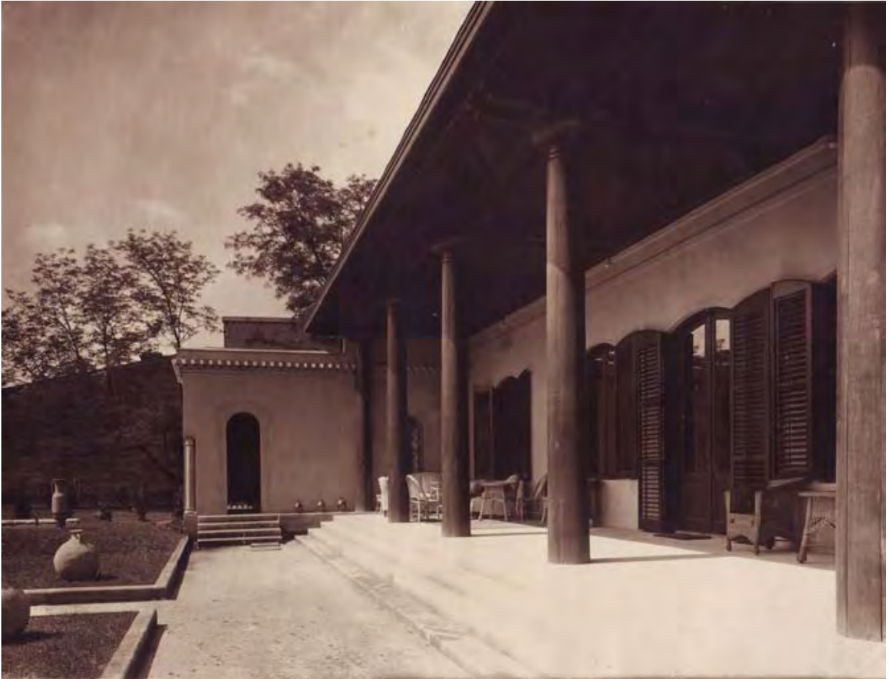
186. GMC/Schmiedigen, Villa Polizu/Königin Elisabeth von Griechenland (1923-1925, 1928-1929). Blick auf die Loggia mit Holzsäulen. Im Hintergrund der Eingang zum Atrium (Aufnahme W. Weiss o. D. [1929]).
