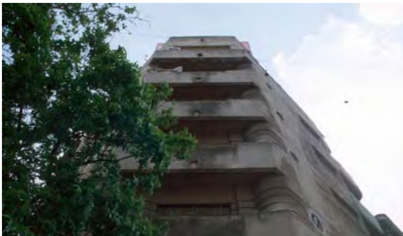
WV 139. Appartementgebäude Str. Vânători 1, Ecke am Platz der Vereinten Nationen. Aufnahme 2008.
