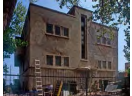
WV 50. Villa „Lilie“, Eingangsfassade. Aufnahme 2008.
