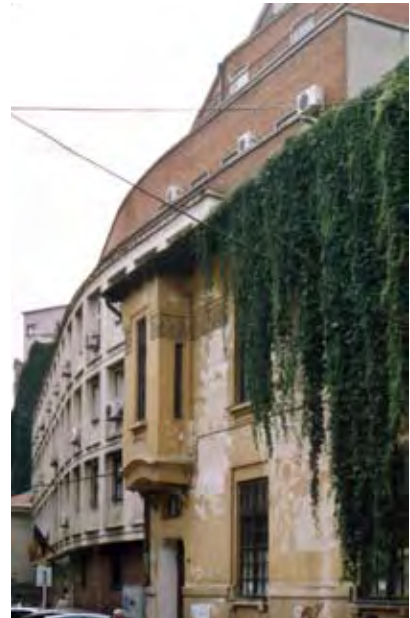
WV 211. Bürogebäude Str. Vasile Lascăr. Aufnahme 2007.
