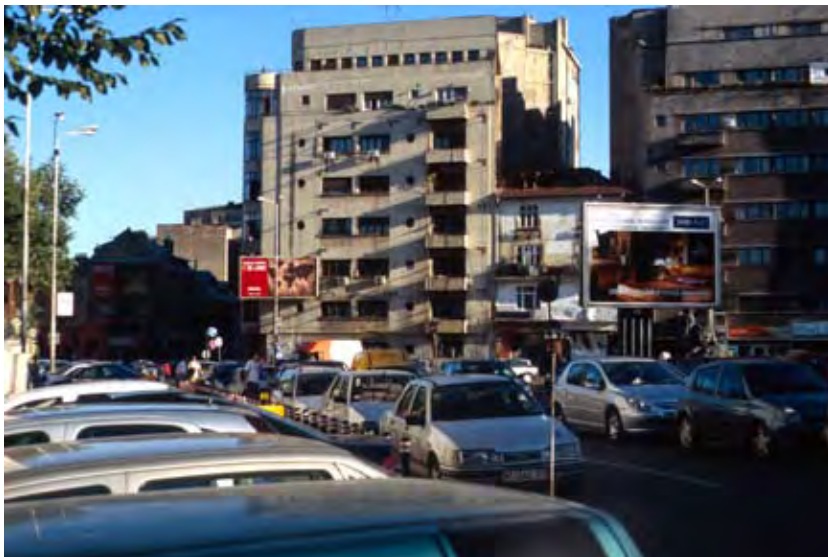
WV 126. Appartementgebäude Bragadiru am Lahovaryplatz. Aufnahme 2008.
