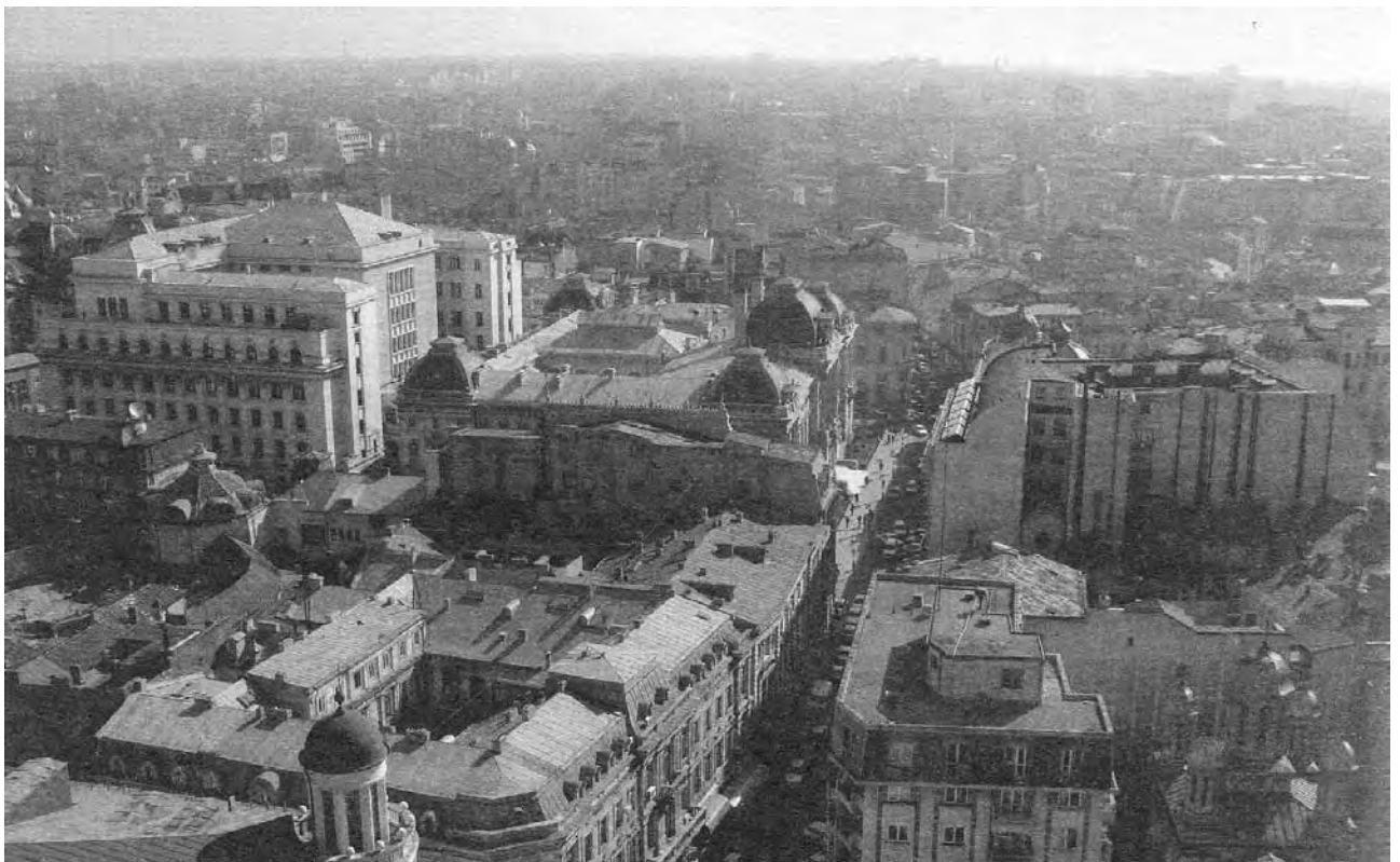
152. Bukarest, Luftbild des Lipscani-Viertels. Blick nach Osten entlang der Lipscani-Straße. Im mittleren Bereich der Aufnahme: der Neubau (links) und der Altbau der Nationalbank (Bildmitte); rechts im Bild die ehemalige Chrissoveloni-Bank (Aufnahme o. J. [2005]).
