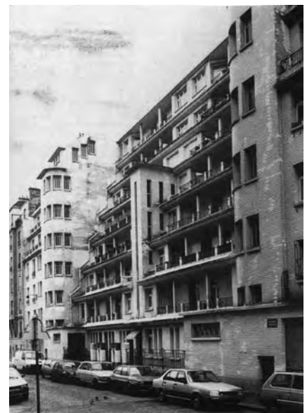
72. Henri Sauvage, Wohnhaus mit Hallenbad, Rue des Amiraux 13, Paris (1916-1926).
