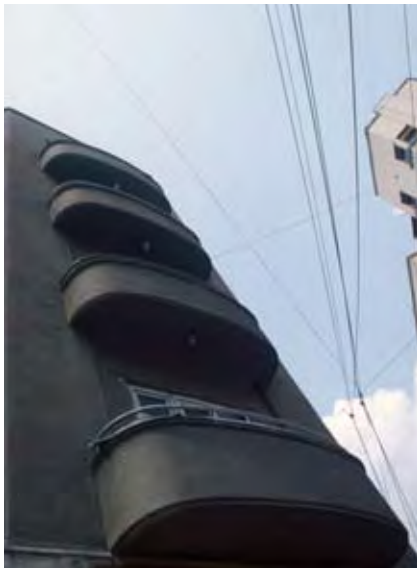
WV 132. Appartementgebäude Kretzulesco, Gebäudeecke nach Osten. Aufnahme 2008.
