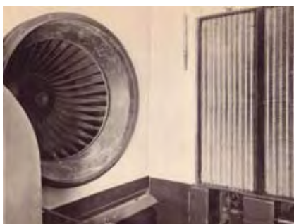
WV 22. Chrissoveloni-Bank, Lüfter und Wasserfilter.
