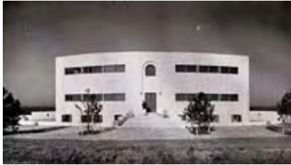
WV 42. Villa Aviana, Eingangsfassade. Aufnahme um 1934.
