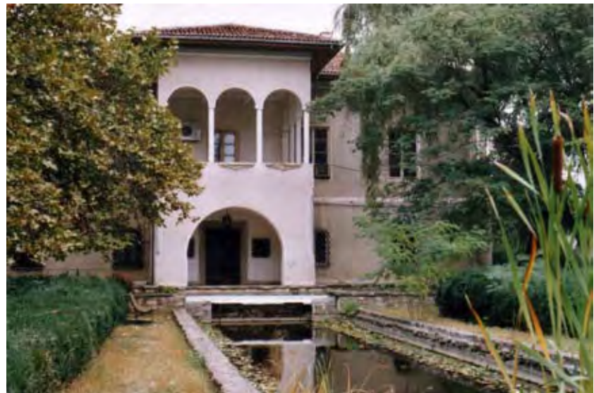
WV 161. Villa Naе Ionescu, Söller und Wasserbecken. Aufnahme 2006.
