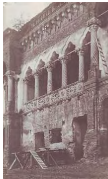
126. Mogoșoia, Baustelle des Palais, 1920er Jahre.
