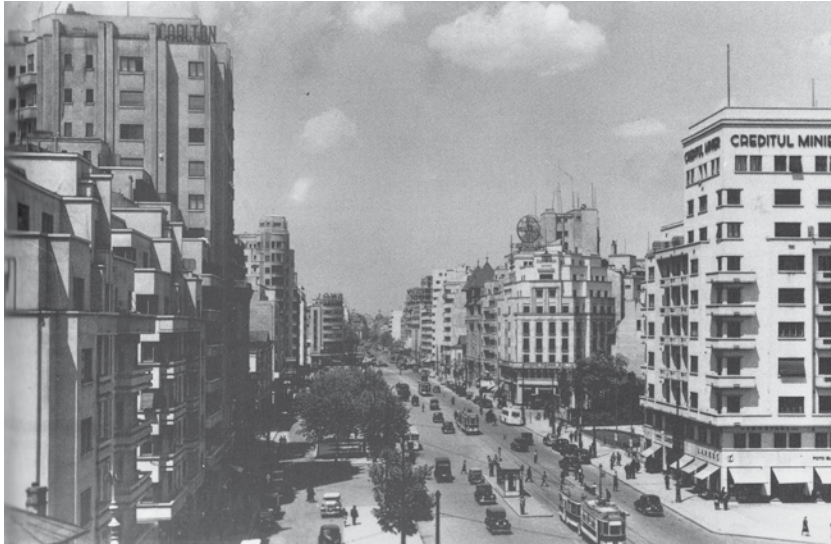
255. Bratianu-Boulevard, Bukarest. Blick nach Norden. Links im Bild GMCs Carlton-Hochhaus (WV, W 40), zerstört im Erdbeben von 1940.
