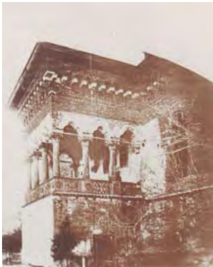
123. Mogoșoaia. Blick auf den Söller vor der Instandsetzung (historische Aufnahme).
