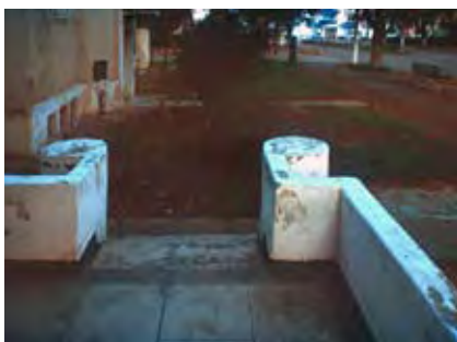
WV 109. Villa Flora, Terrasse mit Treppe hin zur Villa Z. Aufnahme 2006.
