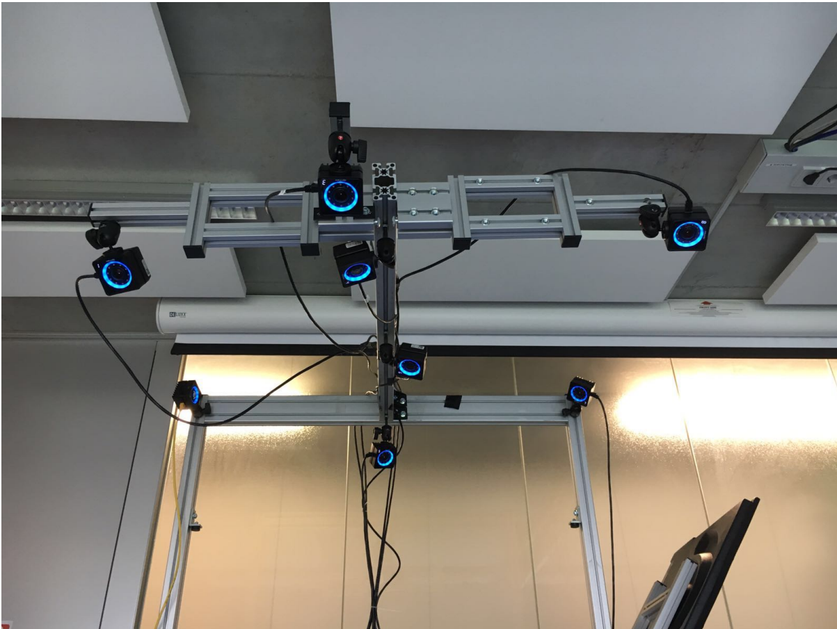
Abbildung 4.2: OptiTrack Kameras, die an einem Gerüst befestigt wurden.
