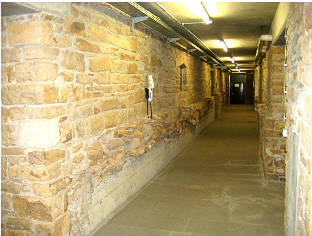
Abb. 454 Untergeschoss Unterfangung der Fundamente mit Beton – beide Fotos: Anton Lang
