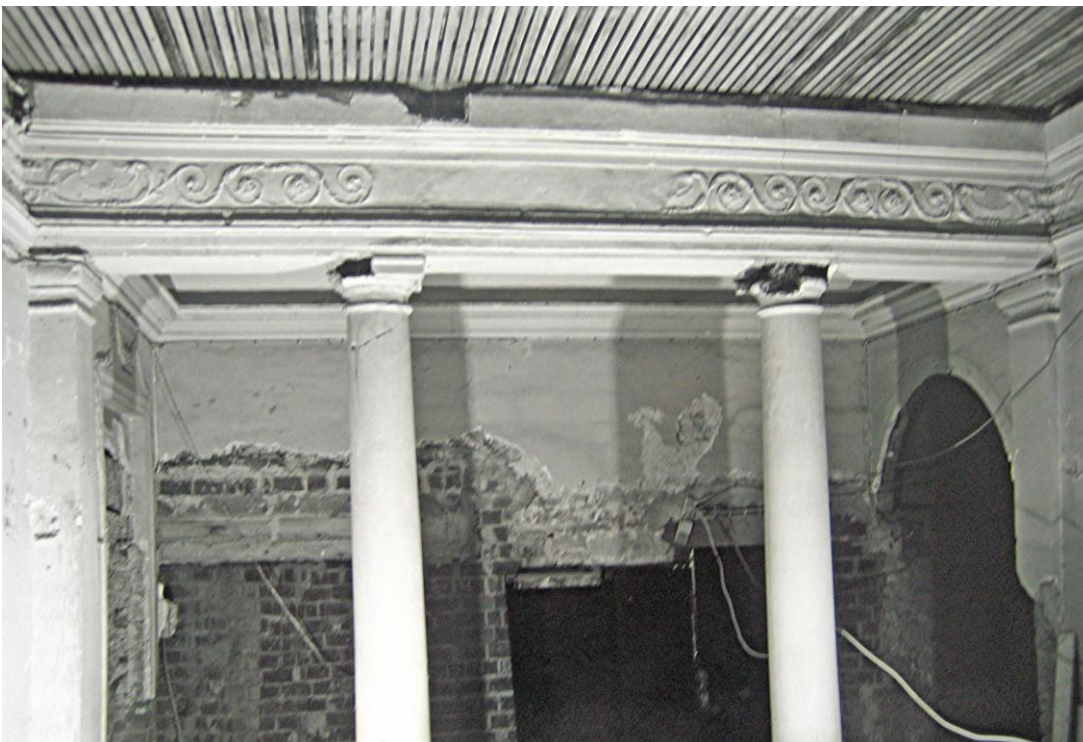
Abb. 436 Erdgeschoss – Altes Treppenhaus – Foto: Gert-Steffen Köhler, Archiv Universität Hohenheim
