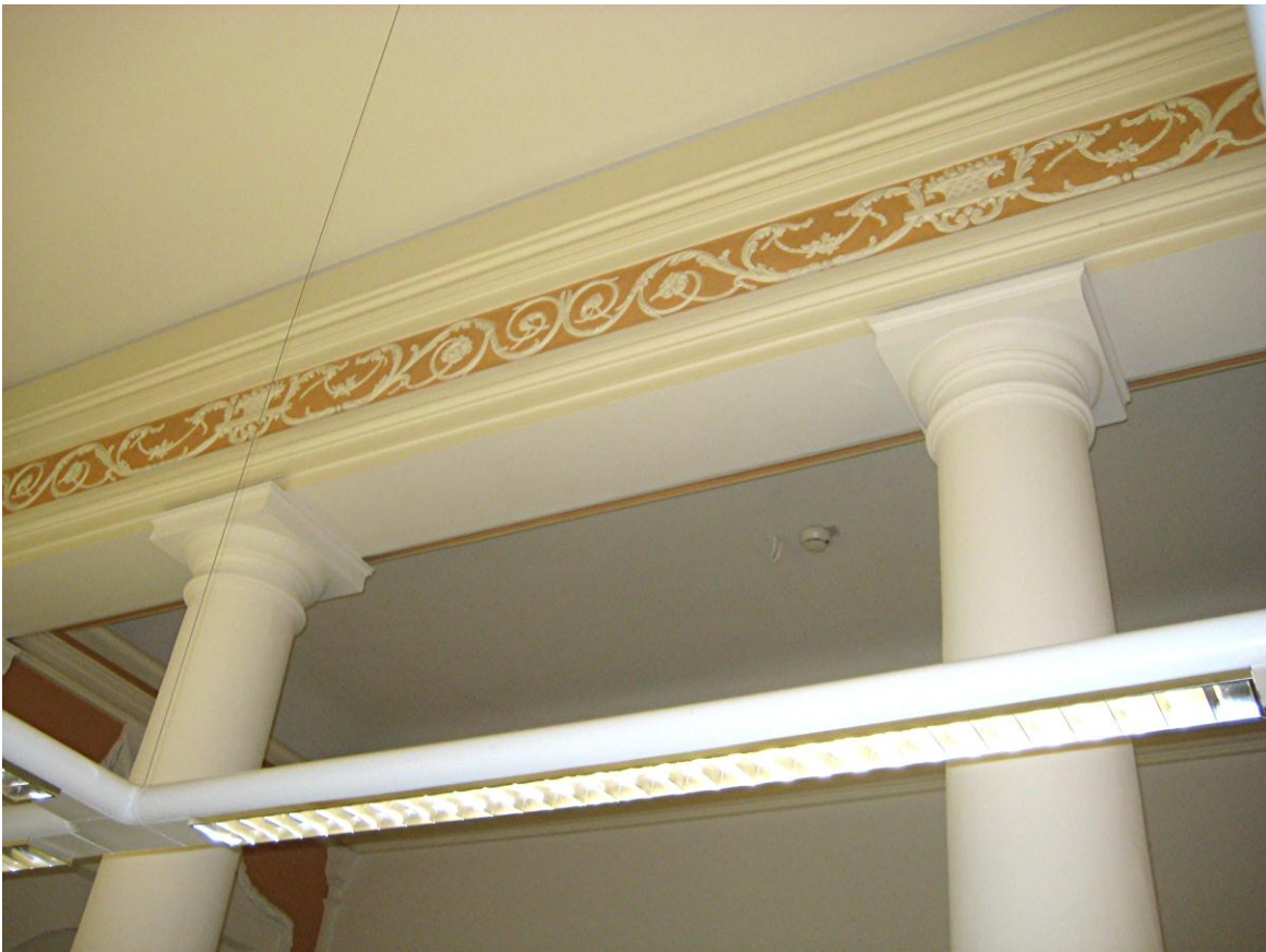
Abb. 447 Erdgeschoss Altes Treppenhaus – Gebälkdetail mit Säulenkapitellen – Foto: Anton Lang
