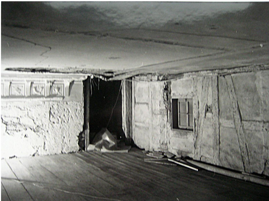
Abb. 404 Bibliothek Zwischenboden – Foto: Gert-Steffen Köhler, Archiv Universität Hohenheim
