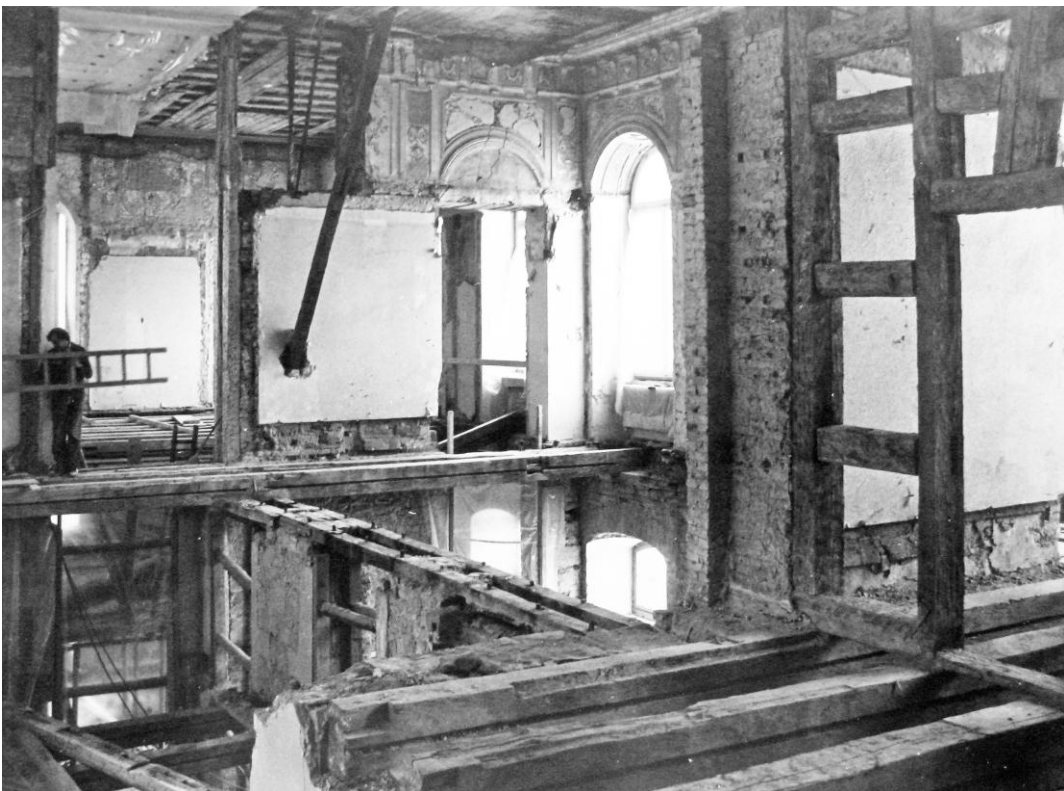
Abb. 406 Bibliothek – Einziehen neuer Balken am Fußboden Foto: Gert-Steffen Köhler Archiv Uni Hohenheim
