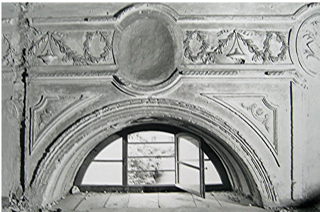
Abb. 415 Registraturzimmer – Bestand über der Zwischendecke – Detail Foto: Gert-Steffen Köhler, Archiv Universität Hohenheim
