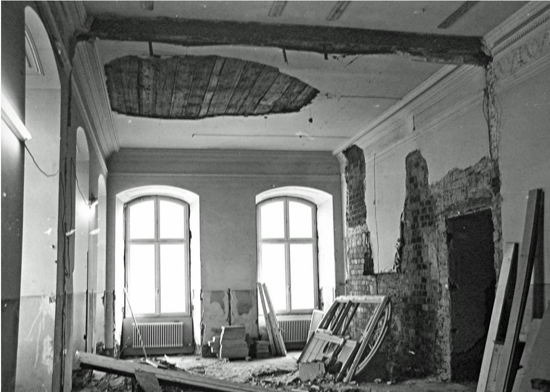
Abb. 435 Erdgeschoss – Beginn der Restaurierung – Foto: Gert-Steffen Köhler, Archiv Universität Hohenheim
