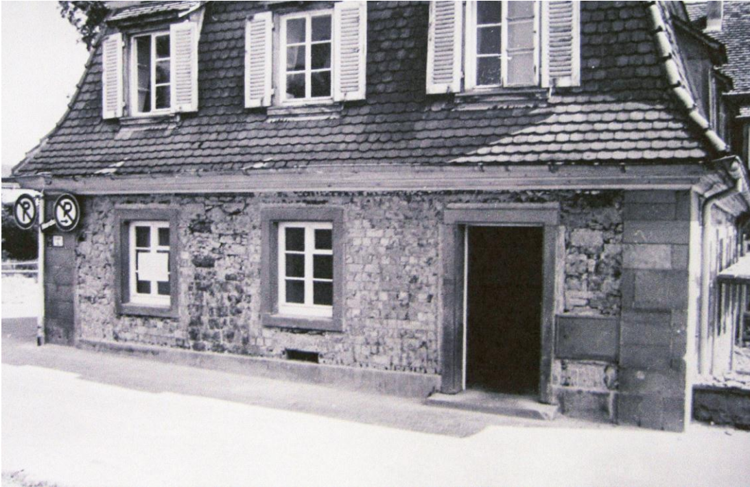
Abb. 481 Speisemeisterei unverputzt. Mit solchen Feldsteinen wurde der erste Schlossflügel erbaut Foto: Gert-Steffen Köhler, Archiv Universität Hohenheim
