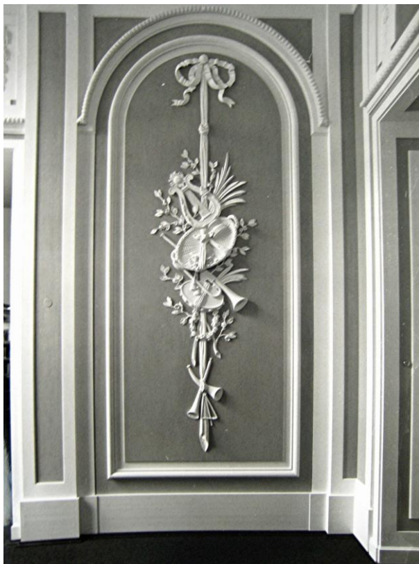
Abb. 425 Altes Treppenhaus Nordseite „Trophäe“ Foto: Gert-Steffen Köhler, Archiv Uni Hohenheim
