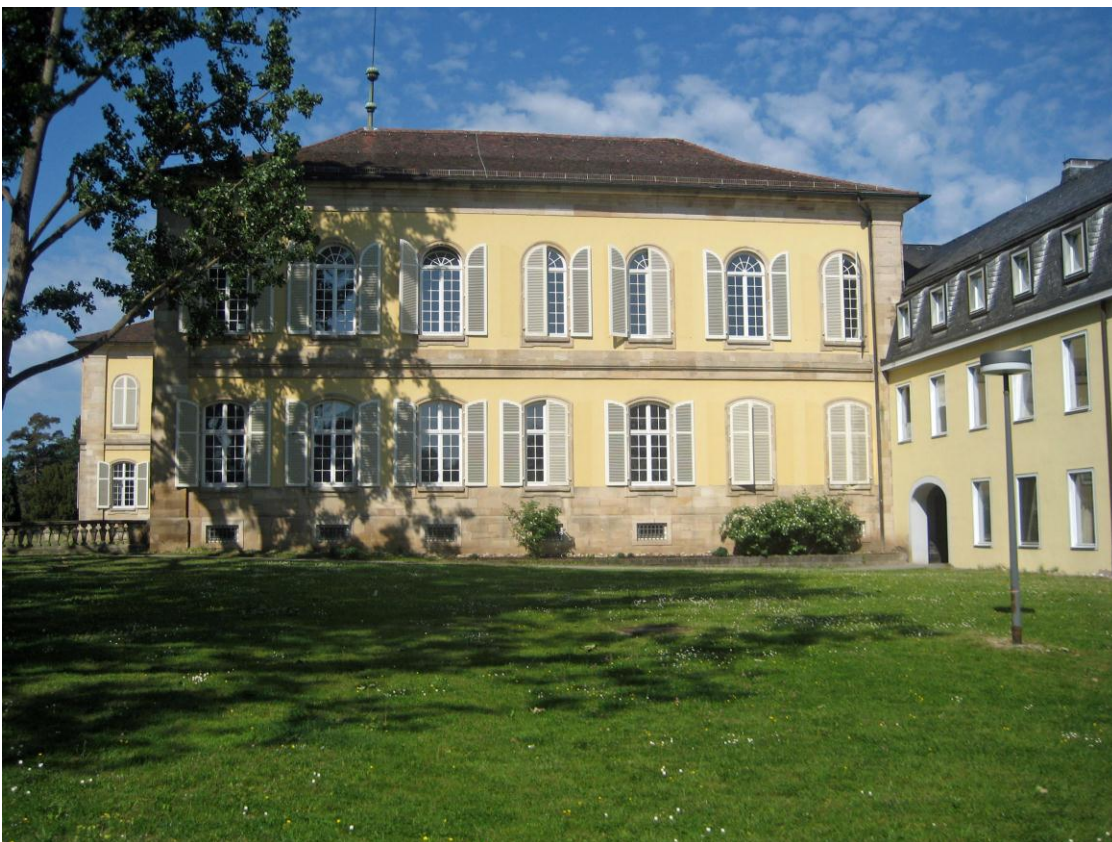
Abb. 460 Ostflügel Ostansicht nach der Restaurierung 1980 – Foto: Anton Lang
