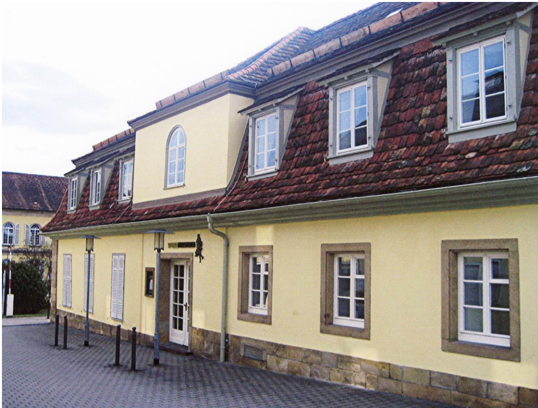
Abb. 483 Speisemeisterei Ostseite Eingang – Foto: Anton Lang
