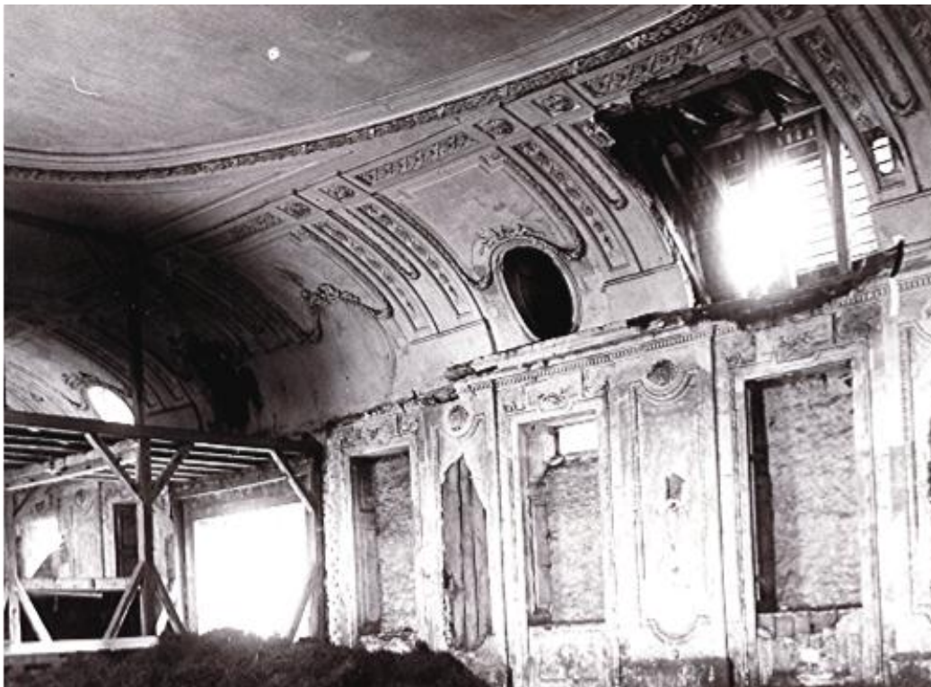
Abb. 60 Zustand der Reithalle vor dem Abbruch – Staatliches Denkmalamt Esslingen
