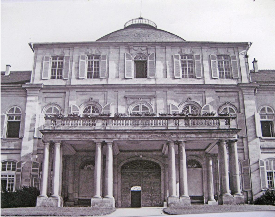
Abb. 202 Mittelbau Südseite Eingang noch mit den alten Brettertüren Foto: Archiv Universität Hohenheim
