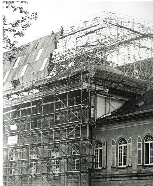
Abb. 252 Das Gerüst wird mit Eternitplatten verkleidet
