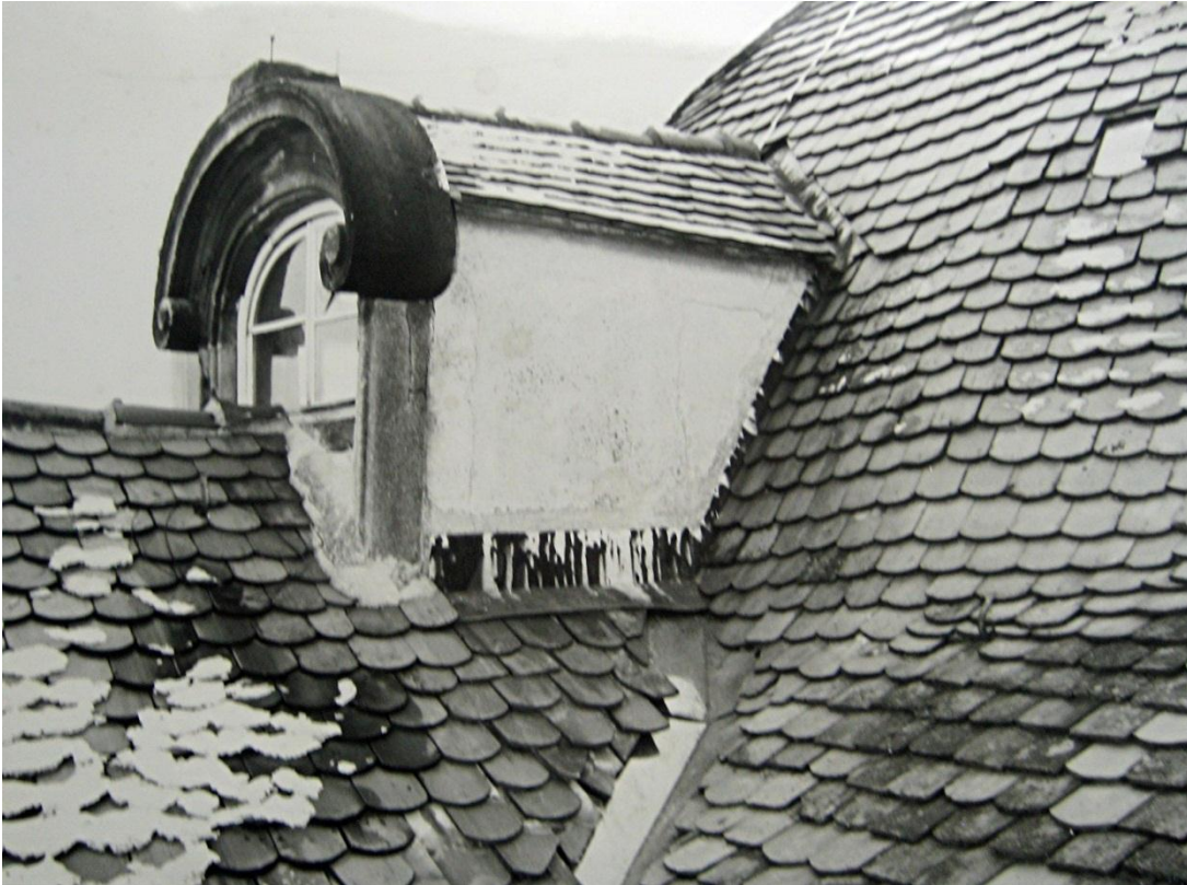
Abb. 250 Kuppel Fenster vor der Sanierung Deckung noch in Ziegel Foto: Gert-Steffen Köhler Archiv Universität Hohenheim
