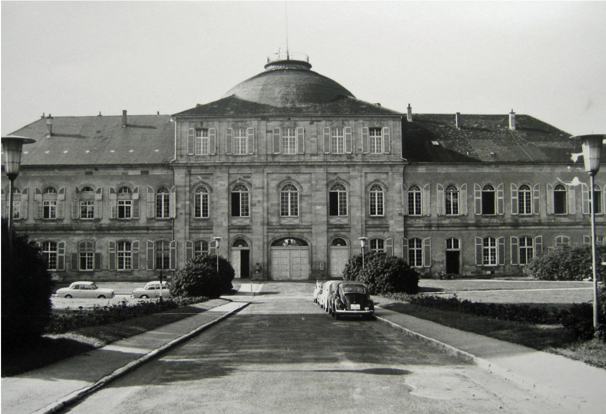
Abb. 197 Der alte Eingangsbereich noch mit Bretttertor und seitlichen zweifüglichen Holztüren Foto: Archiv Universität Hohenheim
