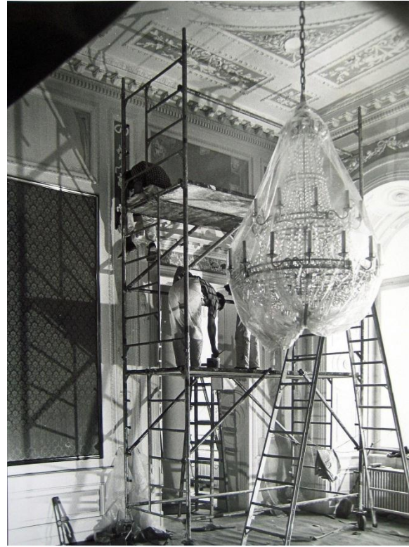
Abb. 209 Arbeiten im Bereich der Tür zum Tempelchen
