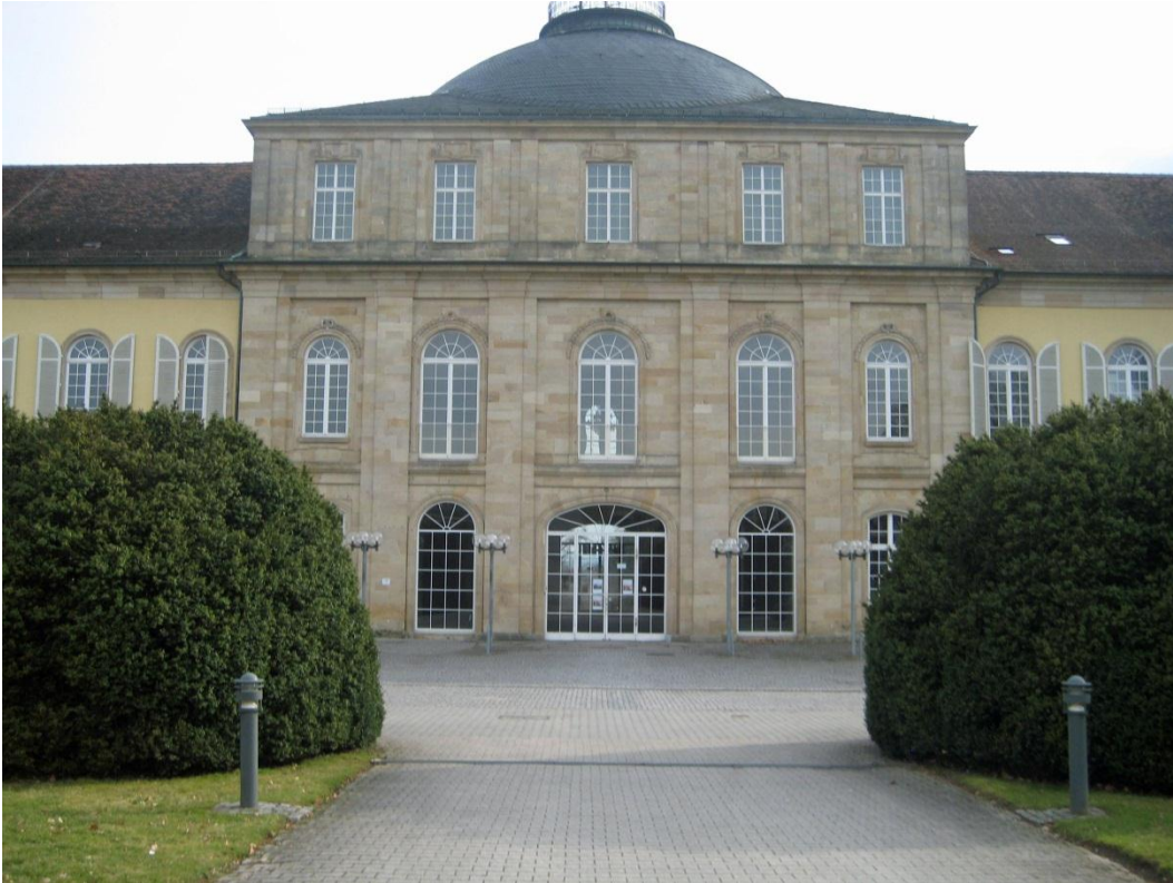
Abb. 200 Schlossmittelbau Nordseite Eingangsbereich neue Eingangstüren Foto: Anton Lang
