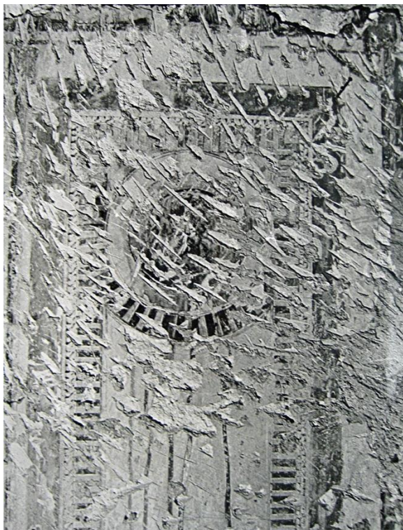
Abb. 184 Blauer Saal Nordwand unter dem abgeschlagenen Gips wird die Scheintür sichtbar Foto: Gert-Steffen Köhler Archiv Uni Hohenheim
