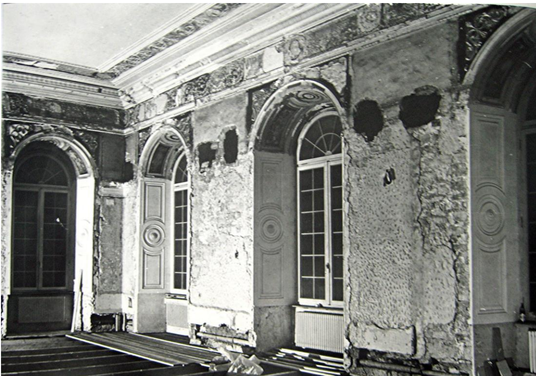
Abb. 221 Grüner Saal Südostecke Foto: Gert-Steffen Köhler Archiv Universität Hohenheim
