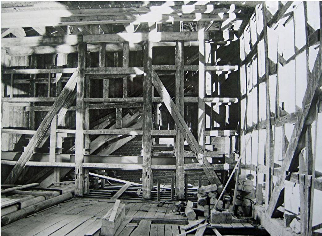
Abb. 254 Sprengwerk unter der Kuppel Foto: Gert-Steffen Köhler Archiv Universität Hohenheim
