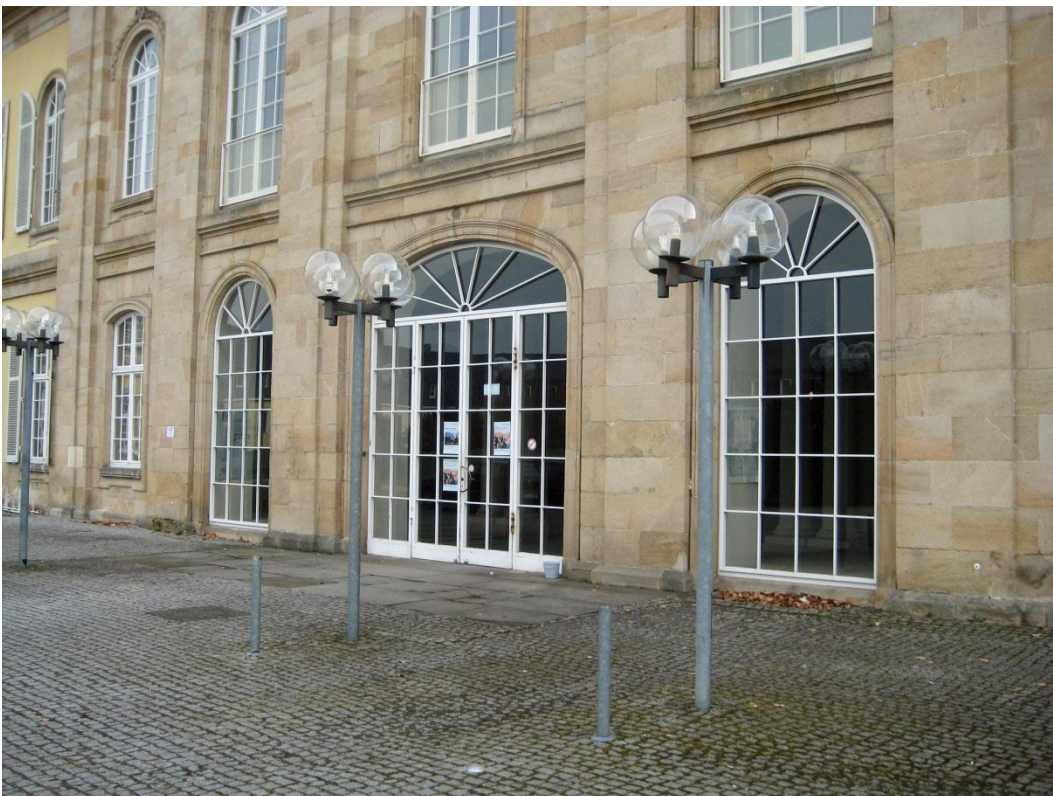
Abb. 201 Eingangsbereich Nordseite Neue verglaste Eingangstür Foto: Anton Lang
