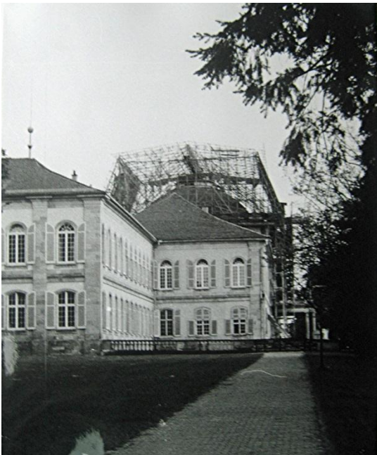
Abb. 251 Stahlrohrgerüst für die Kuppel wird aufgebaut. Foto: Gert-Steffen Köhler Archiv Universität Hohenheim
