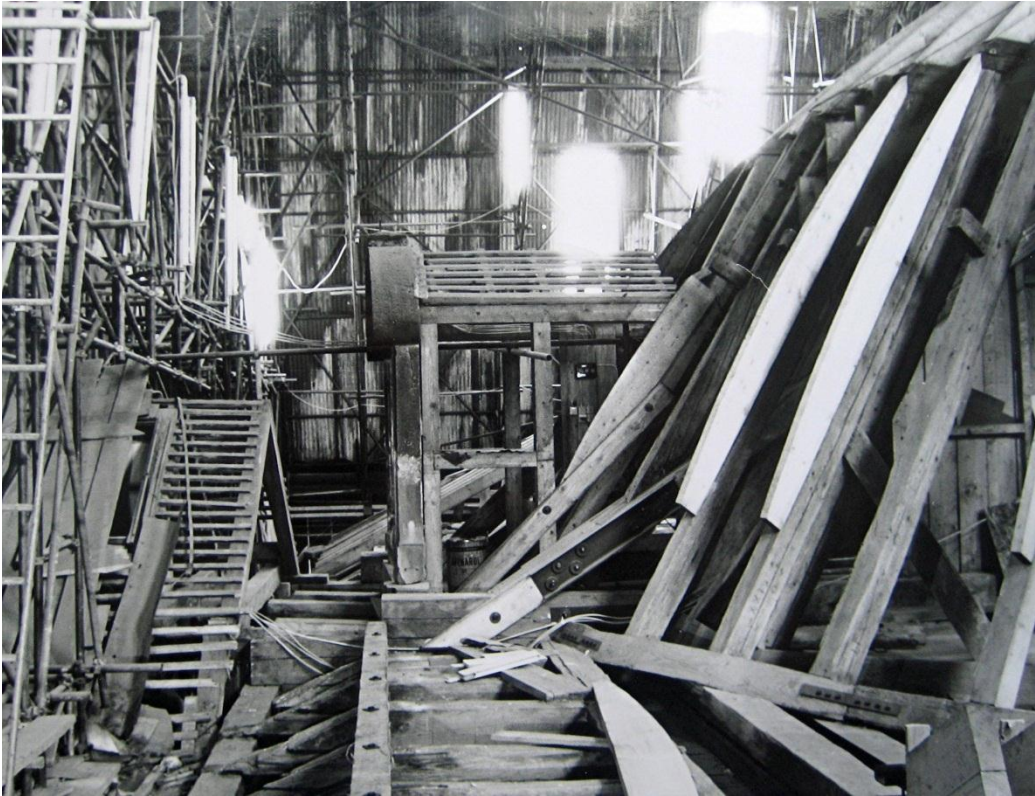
Abb. 253 Die Sparren der Kuppel werden durch bogenförmige Hölzer aufgedoppelt Foto: Gert-Steffen Köhler Archiv der Universität Hohenheim
