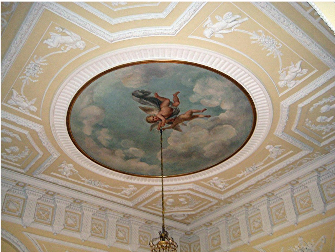
Abb. 240 Treppenhaus das wiederhergestellte Deckenfeld mit dem wiederhergestellten Deckengemälde Foto: Anton Lang
