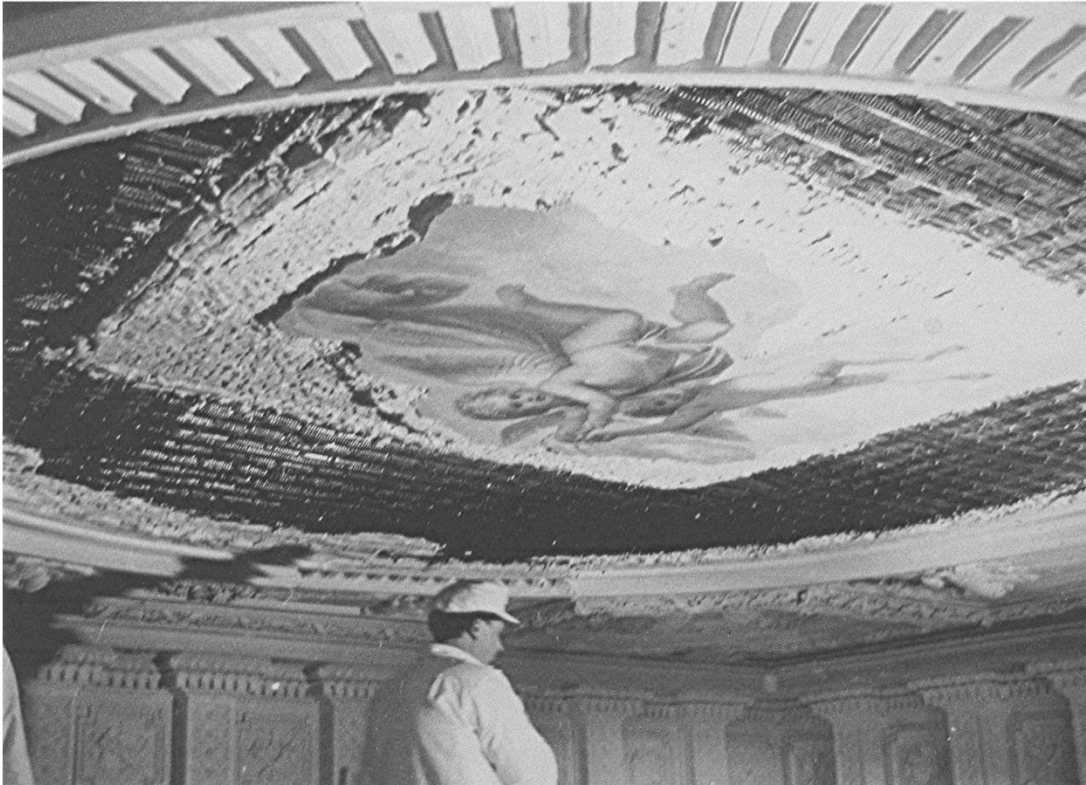
Abb. 239 Treppenhaus Das abgenommene Gemälde ist wieder eingesetzt. Foto: Gert Steffen Archiv Universität Hohenheim
