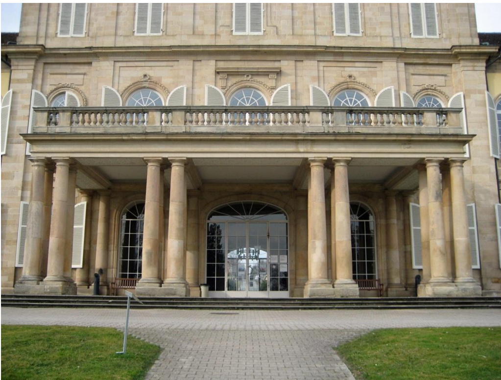
Abb. 203 Mittelbau Südseite Neue verglaste Eingangstüren Foto: Anton Lang
