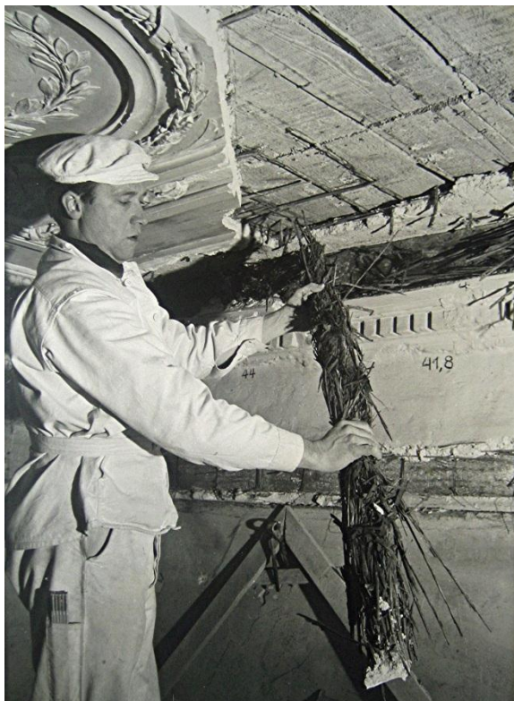
Abb. 186 Altes Schilfrohr wird aus dem Gesims entfernt
