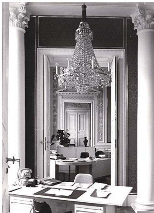
Abb. 229 Durchblick durch das Vorzimmer zum Rektorzimmer Fotos: Gert-Steffen Köhler Archiv Universität Hohenheim
