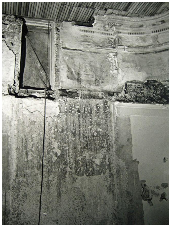
Abb. 183 Zwischendecke ausgeräumt an der Wand Reste der Bemalung Köhler / Archiv
