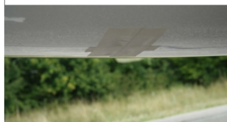
(d) Luftauslass unten abgeklebt
