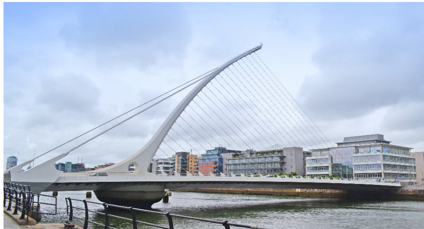
Abb. 2-5: Samuel Beckett Schrägseilbrücke, Dublin (Irland) [eigene Aufnahme]
