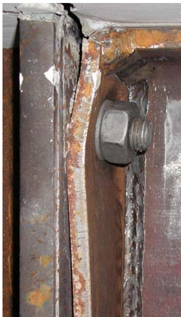
a) Biegezwangsbeanspruchung der Schraube
