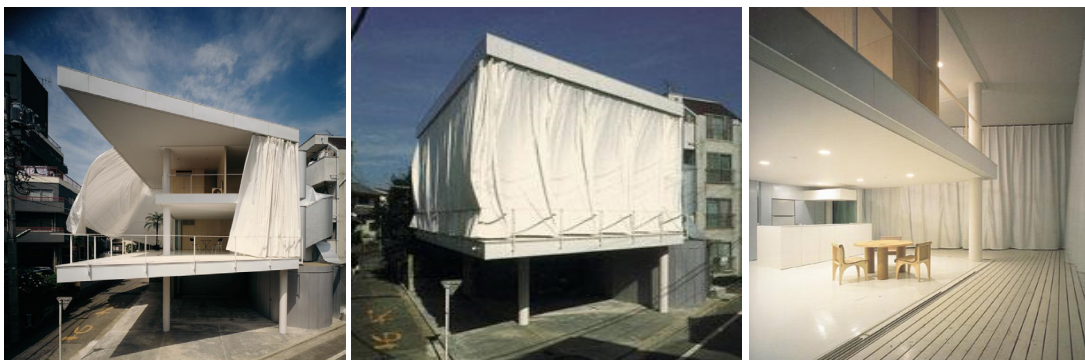
Abbildung 2.16 Curtain-Wall House von Shigeru Ban, Tokio 1995, aus [10]
