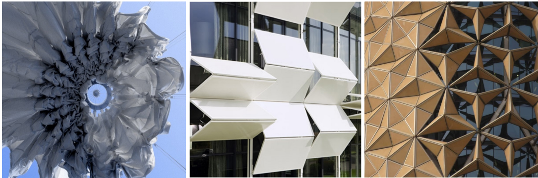
Abbildung 2.13 Entfaltung der Überdachung des Rothenbaum-Stadions, Werner Sobek und Schweger+Partner, Hamburg, 1997, aus [41]
