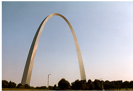
Abbildung 11.9.60: Gateway Arch in St. Louis. Das Bauwerk ist 192 m hoch und 192 m breit. Foto mit freundlicher Genehmigung von C. Haase, www.arrakeen.ch
